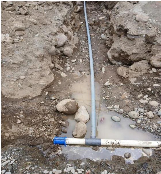
SEPTIEMBRE – 2024. Extensión de red principal de agua potable, tubería PVC de 63mm.
