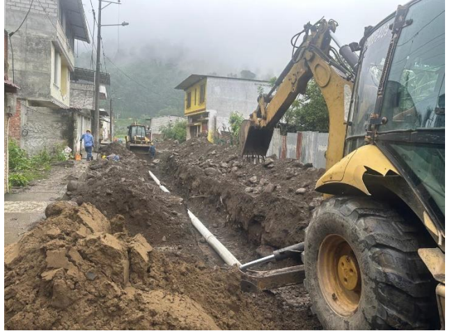
MAYO – 2024. Extensión de red principal a tubería PVC corrugada de 250mm.
