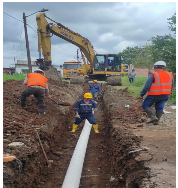
MAYO – 2024. Extensión de red principal a tubería PVC corrugada de 250mm.
