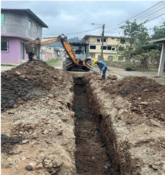
OCTUBRE – 2024. Cambio de tubería en red principal de alcantarillado sanitario de asbesto cemento a tubería PVC corrugada de 250mm.
