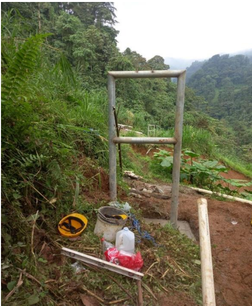
ABRIL – MAYO - JUNIO – 2024. Construcción de paso elevado, 40m.
