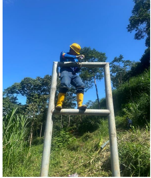
ABRIL – MAYO - JUNIO – 2024. Construcción de paso elevado, 40m.
