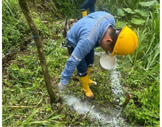
ABRIL – MAYO - JUNIO – 2024. Construcción de paso elevado, 40m.
