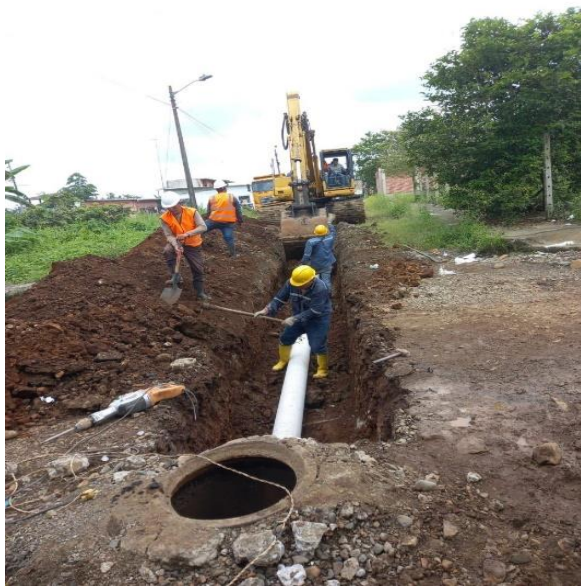
MAYO – 2024. Extensión de red principal a tubería PVC corrugada de 250mm.
