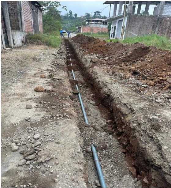
AGOSTO – 2024. Extensión de red principal de agua potable, tubería PVC de 63mm.
