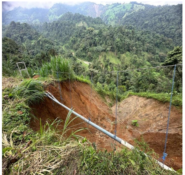
ABRIL – MAYO - JUNIO – 2024. Construcción de paso elevado, 40m.
