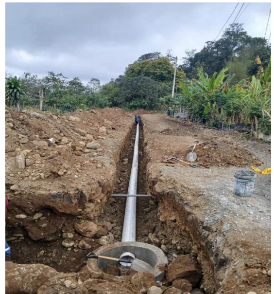
NOVIEMBRE – 2024. Extensión de red principal a tubería PVC corrugada de 250mm, Calle Eloy Chicaiza, Calle A, Calle B y Calle C.
