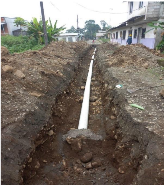
JULIO – 2024. Extensión de red principal a tubería PVC corrugada de 250mm.
