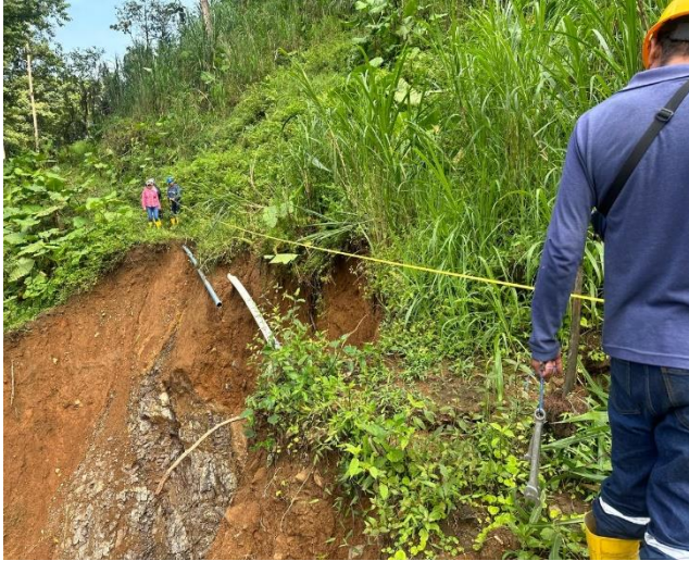
ABRIL – MAYO - JUNIO – 2024. Construcción de paso elevado, 40m.
