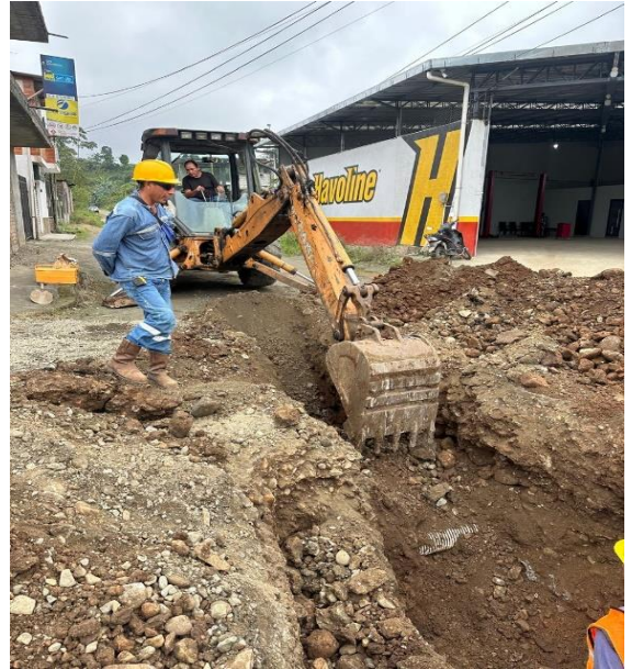
AGOSTO – 2024. Extensión de red principal de agua potable, tubería PVC de 63mm.
