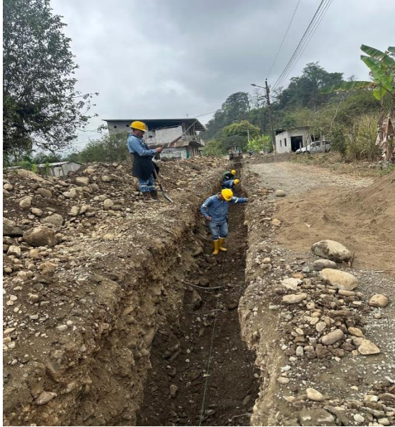
NOVIEMBRE – 2024. Extensión de red principal a tubería PVC corrugada de 250mm, Calle Eloy Chicaiza, Calle A, Calle B y Calle C.
