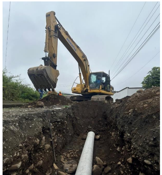
JULIO – 2024. Extensión de red principal a tubería PVC corrugada de 250mm.
