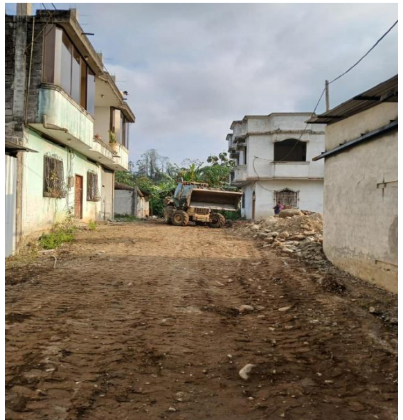
SEPTIEMBRE – 2024. Extensión de red principal de agua potable, tubería PVC de 63mm.
