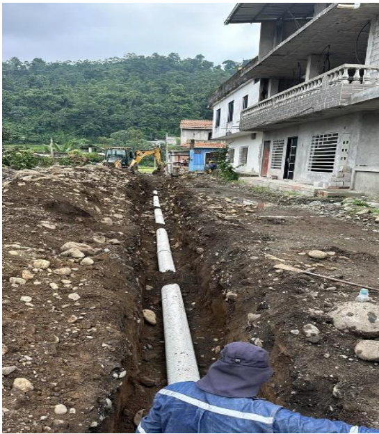
MAYO – 2024. Extensión de red principal a tubería PVC corrugada de 250mm.
