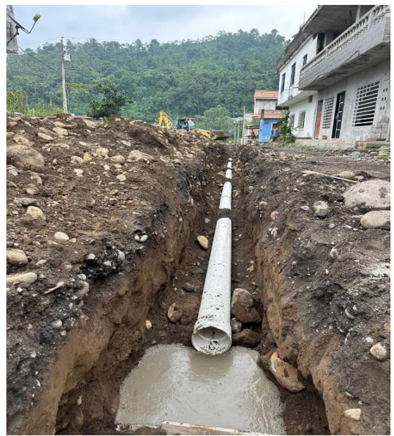
MAYO – 2024. Extensión de red principal a tubería PVC corrugada de 250mm.
