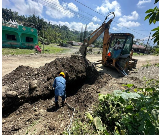
4 AGOSTO – 2023. EXCAVACION PARA REALIZAR 2 GUÍAS DE AGUA POTABLE Y 3 DE ALCANTARILLADO SANITARIO, DIFERENTES PARTES DEL CANTON
