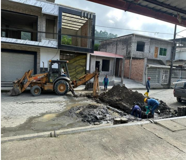
3 AGOSTO – 2023. EXCAVACION PARA REALIZAR 2 GUÍAS DE AGUA POTABLE EN SUELO ADOQUINADO EN DIFERENTES PARTES DEL CANTON
