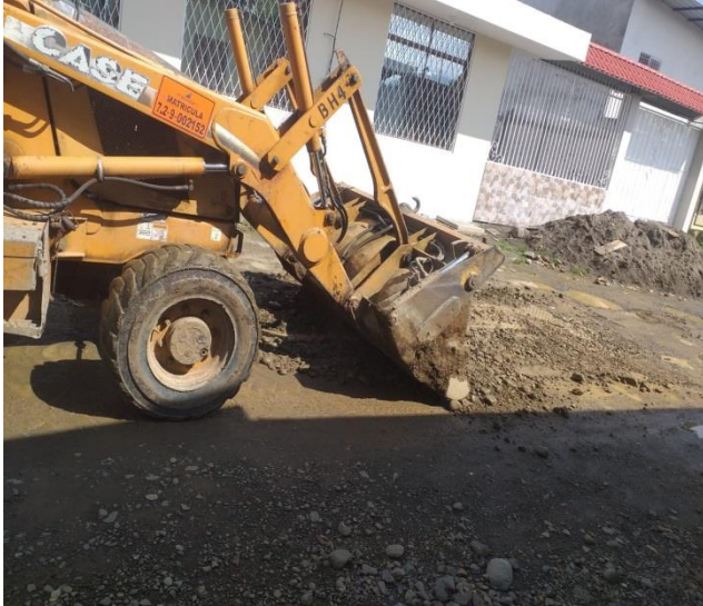
22 JUNIO – 2023. RELLENO Y NIVELACION DE ZANJA EN LA CALLE; 28 DE ENERO Y 4 DE DICIEMBRE.
