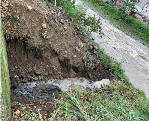
4 ABRIL – 2023. LIMPIEZA DE LOS DESFOGUES DE ALCANTARILLADO SANITARIO, BARRIO PLANTA BAJA
