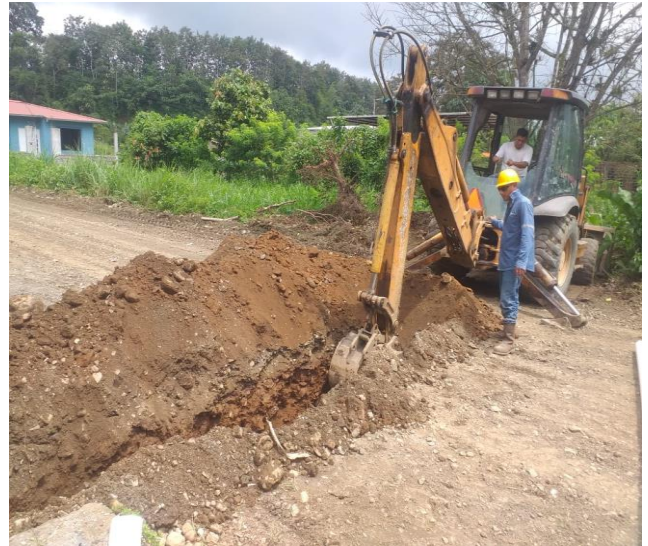
20 JULIO – 2023. EXCAVACION PARA REALIZAR GUÍAS DE AGUA POTABLE Y DE ALCANTARILLADO SANITARIO, DIFERENTES PARTES DEL CANTON
