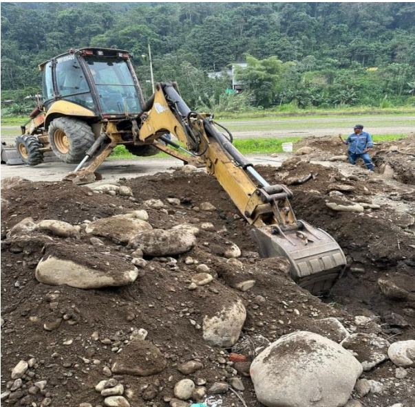
24 OCTUBRE – 2023. EXCAVACION PARA GUIA DE AGUA POTABLE SR. SANCHEZ IBARRA EN 28 DE ENERO.
