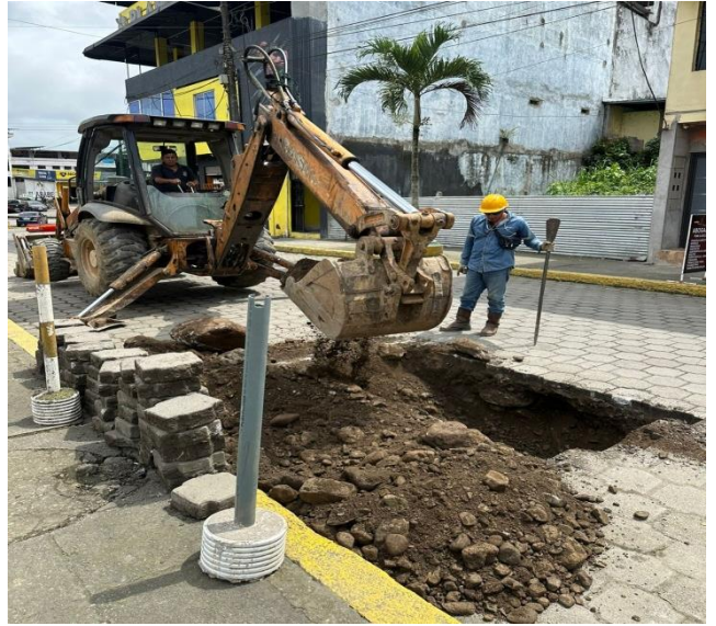
21 NOVIEMBRE – 2023. EXCAVACION PARA RESOLVER ALCANTARILLADO COLAPSADO SR. DAQUI CAMELIA, EN LA CALLE 9 DE OCTUBRE
