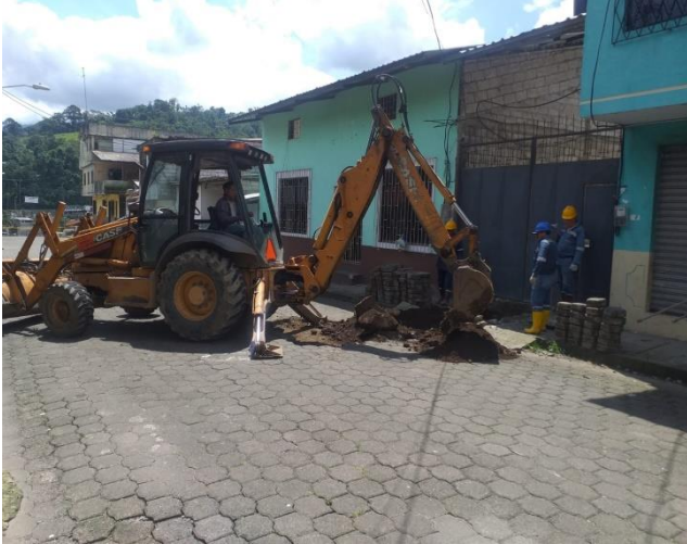
20 ABRIL – 2023. EXCAVACION PARA REALIZAR 3 GUIAS NUEVAS DE AGUA POTABLE, EN DIFERENTES PARTES DEL CANTON CUMANDA.
