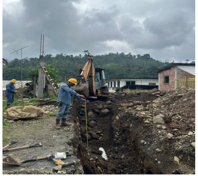
6 DICIEMBRE – 2023. EXTENSION DE RED DE ALCANTARILLADO EN CALLEJON S/N EN LA CALLE 4 DE DICIEMBRE Y 28 DE ENERO, PARA GUIAS DE SR. CAZORLA PAREDES ANA MERCEDES
