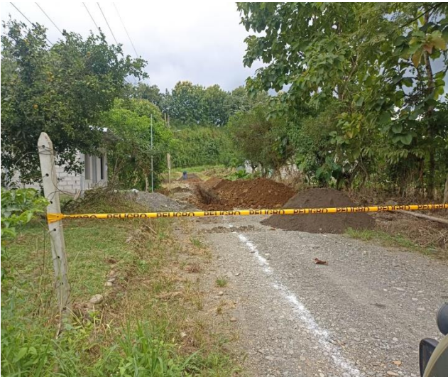
5 MAYO – 2023. EXCAVACION Y RELLENO POR EXTENSION DE RED DE ALCANTARILLADO SANITARIO, SECTOR DIVINO NIÑO, CALLE CARLOS ESPINOZA.
