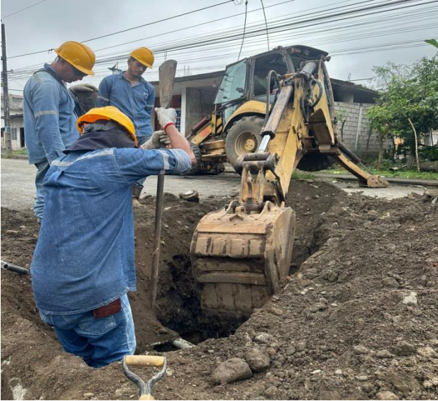
5 DICIEMBRE – 2023. EXTENSION DE RED DE ALCANTARILLADO EN CALLEJON S/N EN LA CALLE 4 DE DICIEMBRE Y 28 DE ENERO, PARA GUIAS DE SR. CAZORLA PAREDES ANA MERCEDES
