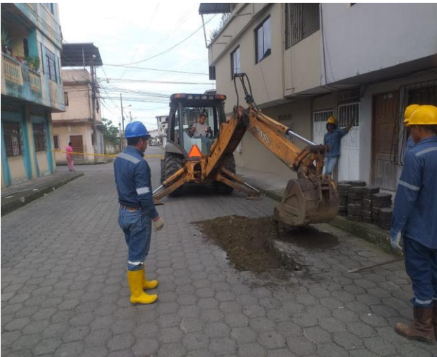
11 ABRIL – 2023. EXCAVACION PARA REALIZAR 1 GUIA NUEVA DE AGUA POTABLE, Y 2 DE ALCANTARILLADO SANITARIO; EN DIFERENTES PARTES DEL CANTON CUMANDA.
