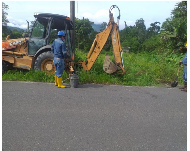
12 ABRIL – 2023. EXCAVACION PARA REALIZAR 3 GUIAS NUEVAS DE ALCANTARILLADO SANITARIO, EN DIFERENTES PARTES DEL CANTON CUMANDA
