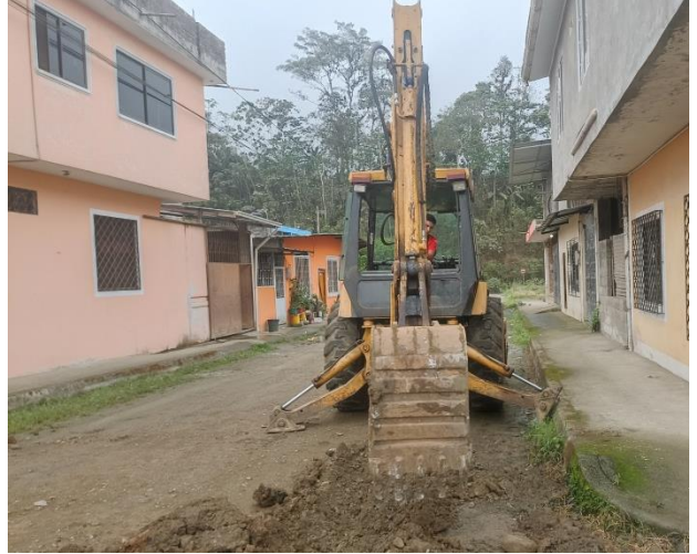
21 ABRIL – 2023. EXCAVACION PARA REALIZAR 3 GUIAS NUEVAS DE AGUA POTABLE, EN DIFERENTES PARTES DEL CANTON CUMANDA.
