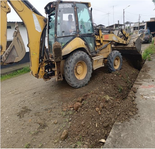
26 SEPTIEMBRE – 2023. EXCAVACION PARA GUIA DE AGUA Y EXCAVACION PARA GUIA ALCANTARILLADO SANITARIO, SECTOR PLANTA BAJA.
