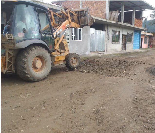
18 JULIO – 2023. TRASLADO DE MATERIAL PARA RELLENO DE ZANJA Y NIVELACION.
