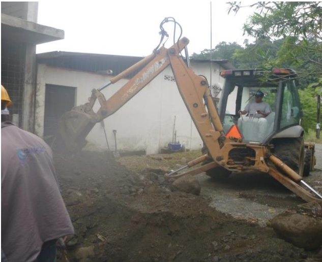
24 ABRIL – 2023. EXCAVACION PARA REALIZAR 1 GUIA NUEVA DE AGUA POTABLE, Y 3 DE ALCANTARILLADO SANITARIO; EN DIFERENTES PARTES DEL CANTON CUMANDA.
