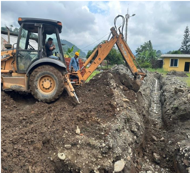
7 DICIEMBRE – 2023. EXTENSION DE RED DE ALCANTARILLADO EN CALLEJON S/N EN LA CALLE 4 DE DICIEMBRE Y 28 DE ENERO, PARA GUIAS DE SR. CALDERON COBO ANA
