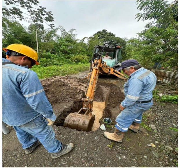
27 SEPTIEMBRE – 2023. EXCAVACION PARA GUIA DE AGUA Y EXCAVACION PARA GUIA ALCANTARILLADO SANITARIO, SECTOR PLANTA BAJA.
