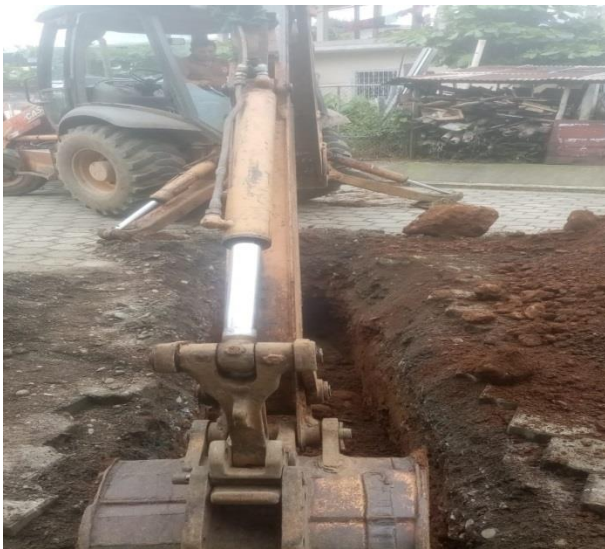
20 JUNIO – 2023. EXCAVACION PARA REPARACION DE FUGA DE AGUA EN LA CALLE; FRANCISCO CHAVEZ.
