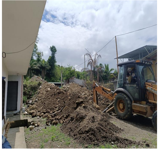
11 DICIEMBRE – 2023. EXCAVACION PARA INSTALACION DE GUIAS DE AGUA POTABLE, SRA. RAMON ALVAREZ VERONICA, EN CALLES P.V. MALDONADO Y ABDON CALDERON
