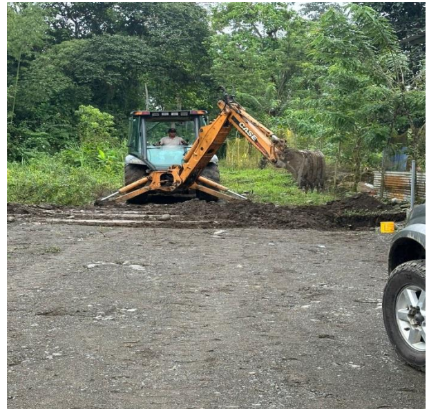
25 OCTUBRE – 2023. EXCAVACION PARA FUGA DE AGUA EN EL SECTOR BRISAS DEL CHIMBO, RED PRINCIPAL
