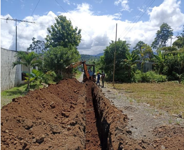
4 MAYO – 2023. EXCAVACION PARA EXTENSION DE RED DE ALCANTARILLADO SANITARIO, SECTOR DIVINO NIÑO, CALLE CARLOS ESPINOZA.
