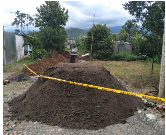
5 MAYO – 2023. EXCAVACION Y RELLENO POR EXTENSION DE RED DE ALCANTARILLADO SANITARIO, SECTOR DIVINO NIÑO, CALLE CARLOS ESPINOZA.
