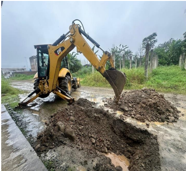
23 NOVIEMBRE – 2023. EXCAVACION PARA SOLUCIONAR FUGA DE AGUA EN COLLARIN, EN SECTOR DIVINO NIÑO
