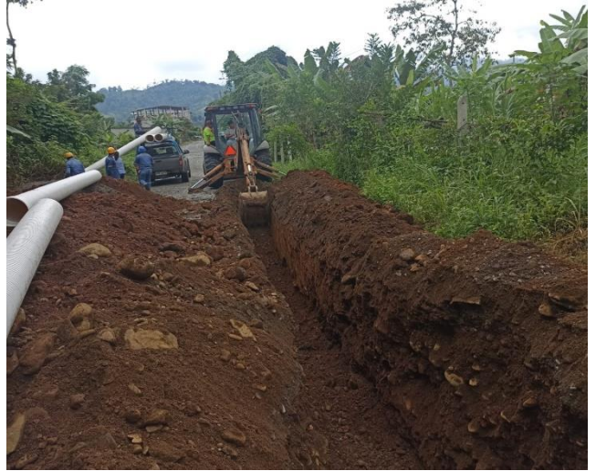
4 MAYO – 2023. EXCAVACION PARA EXTENSION DE RED DE ALCANTARILLADO SANITARIO, SECTOR DIVINO NIÑO, CALLE CARLOS ESPINOZA.
