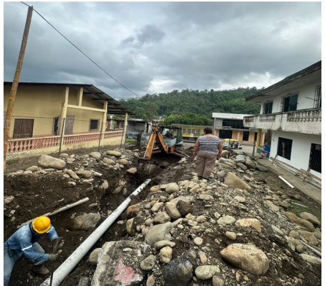
8 DICIEMBRE – 2023. EXTENSION DE RED DE ALCANTARILLADO EN CALLEJON S/N EN LA CALLE 4 DE DICIEMBRE Y 28 DE ENERO, PARA GUIAS DE SR. BERRONES TENESACA ELADIO
