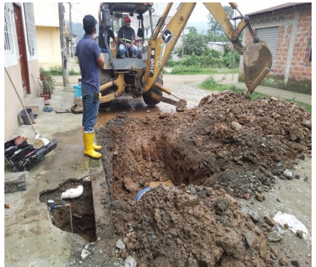
21 JUNIO – 2023. EXCAVACION PARA REPARACION DE FUGA DE AGUA EN LA CALLE; 28 DE NERO Y 4 DE DICIEMBRE.
