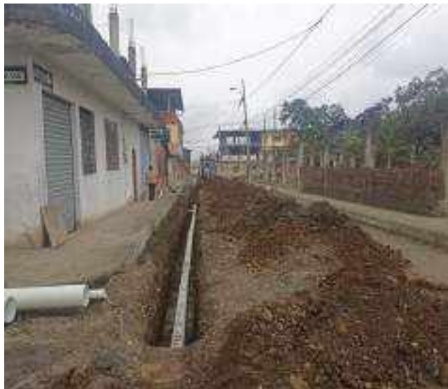
1 DICIEMBRE – 2022. RELLENO POR CAMBIO DE RED DE ALCANTARILLADO SANITARIO, CALLE; CELINDA MUÑOZ ENTRE ABDON CALDERON Y CALLEJON PEATONAL.
