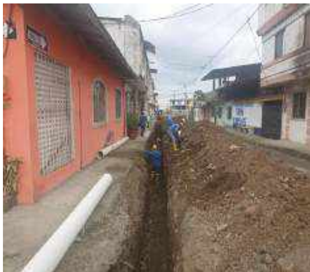
30 NOVIEMBRE – 2022. RELLENO POR CAMBIO DE RED DE ALCANTARILLADO SANITARIO, CALLE; CELINDA MUÑOZ ENTRE PRIMERA CONSTITUYENTE Y ABDON CALDERON.
