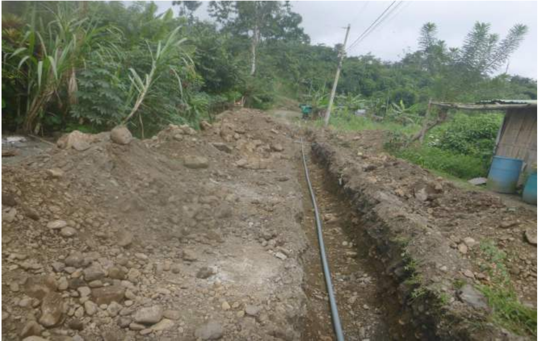
Calle S/N – Sector Brisas del Chimbo
