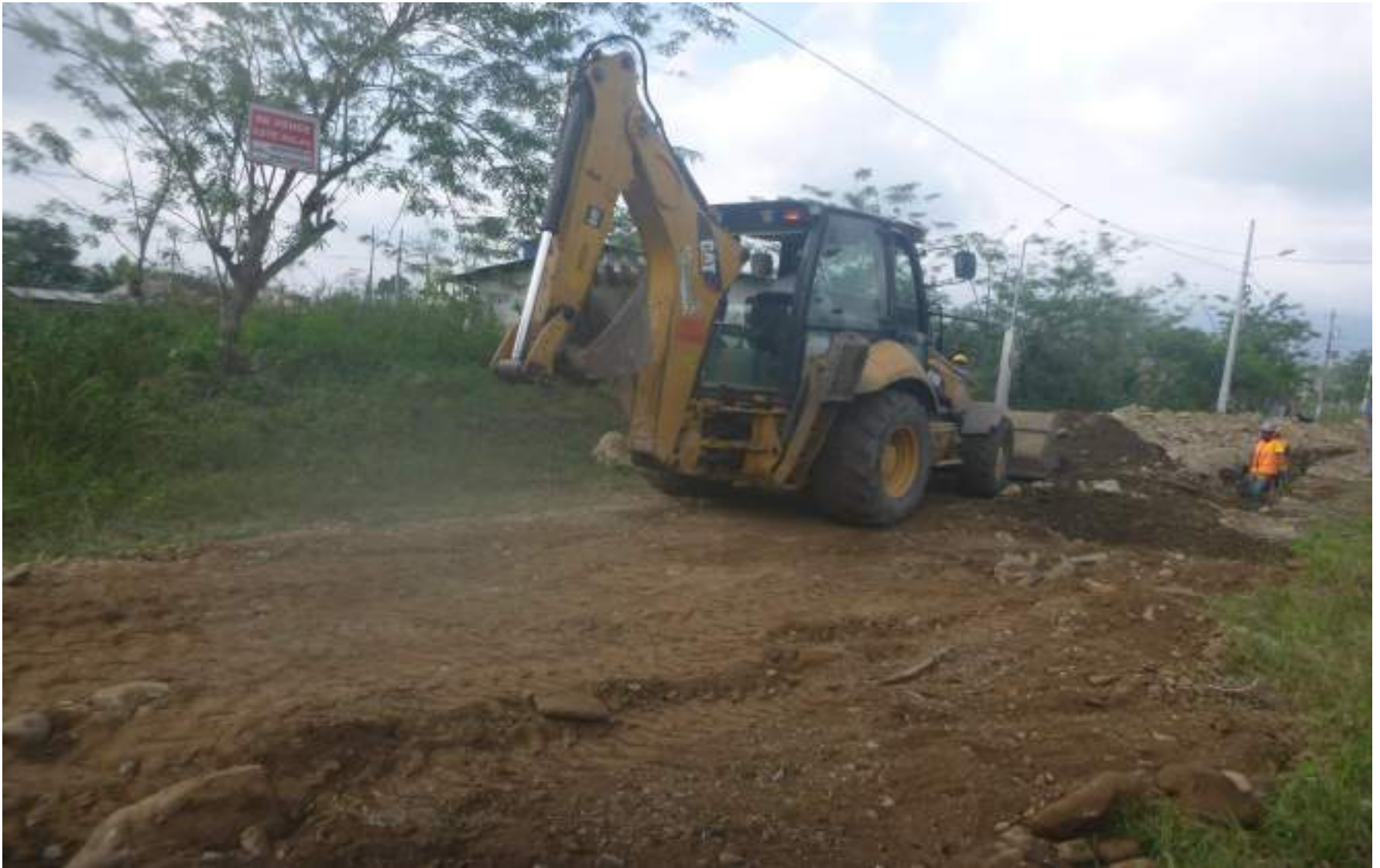
Calle S/N – Sector Brisas del Chimbo
