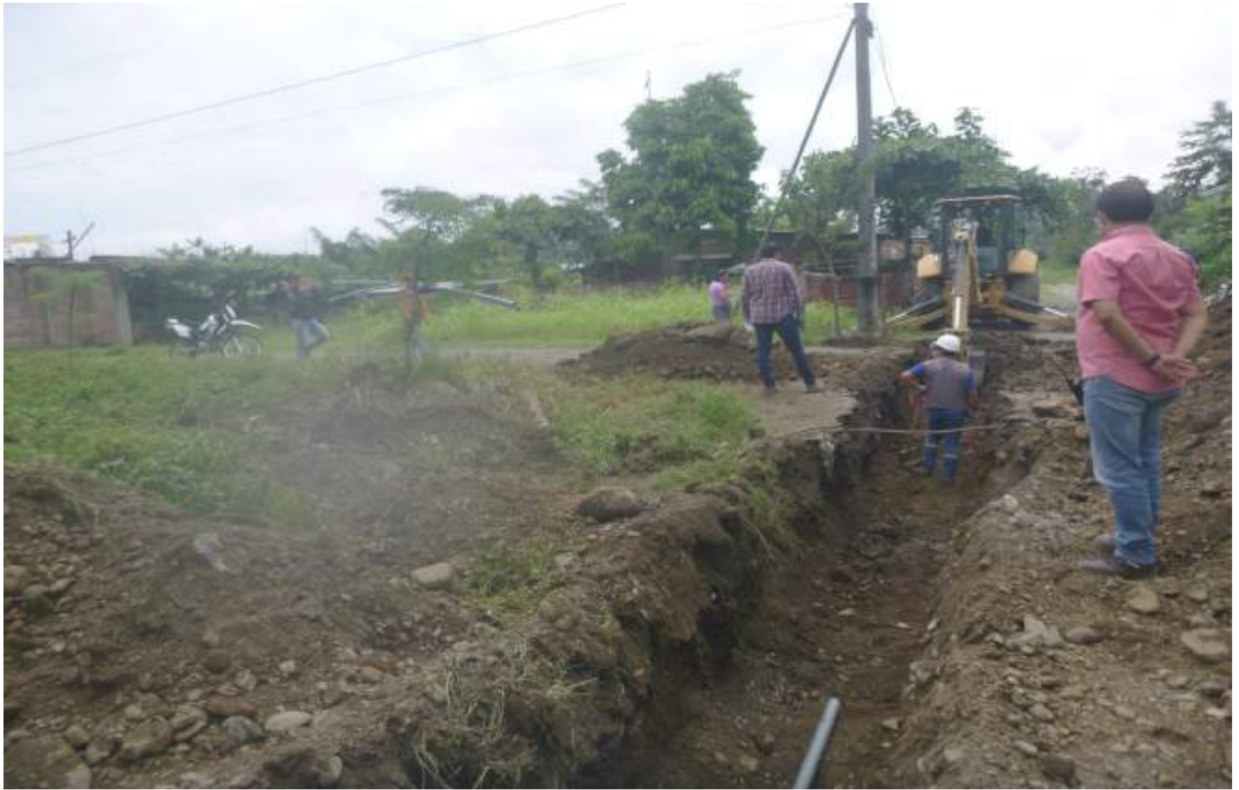
Calle S/N – Sector Brisas del Chimbo
