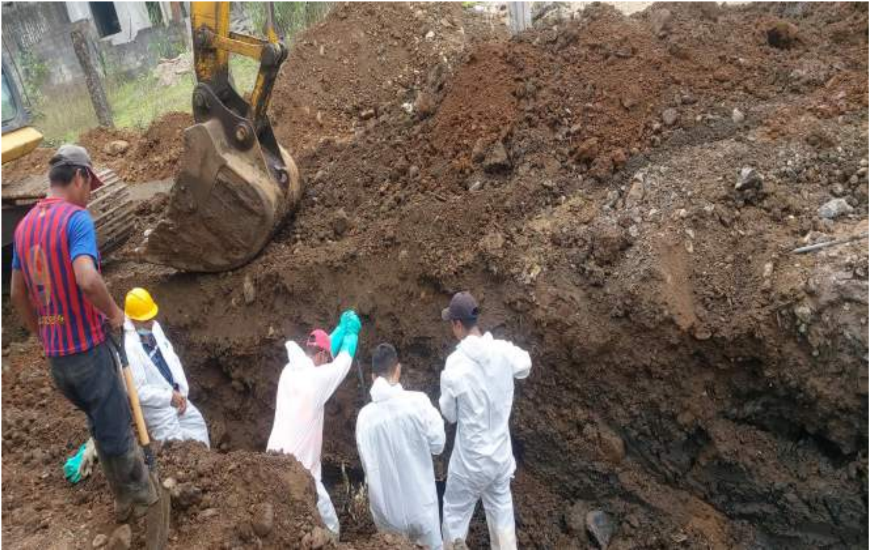
Instalación de by pass – calle Primero de Mayo y Francisco Chavez
