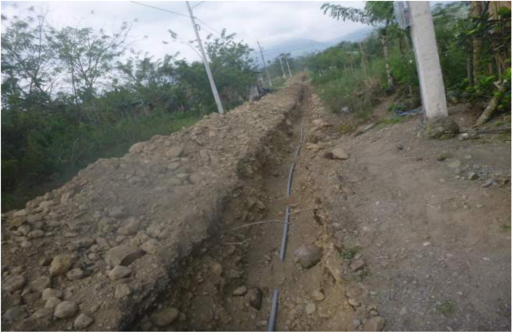
Calle S/N – Sector Brisas del Chimbo
