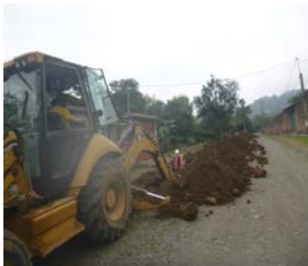
24 Agosto – 2020. Excavación por extensión de red en el sector El Carmen, Vía Buenos Aires. Maquinaria Alquilada.
