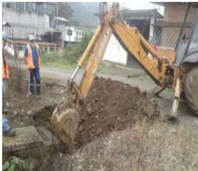
4 Mayo – 2020. Excavación Por alcantarillado sanitario colapsado, en la calle 24 de Mayo y 9 de Octubre, Maquinaria Alquilada.
