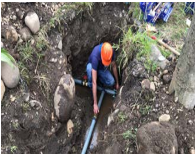
3 Junio – 2020. Excavación para instalar nueva red de agua potable junto a lotización Frutipan , vía Buenos Aires, Maquinaria Municipal
