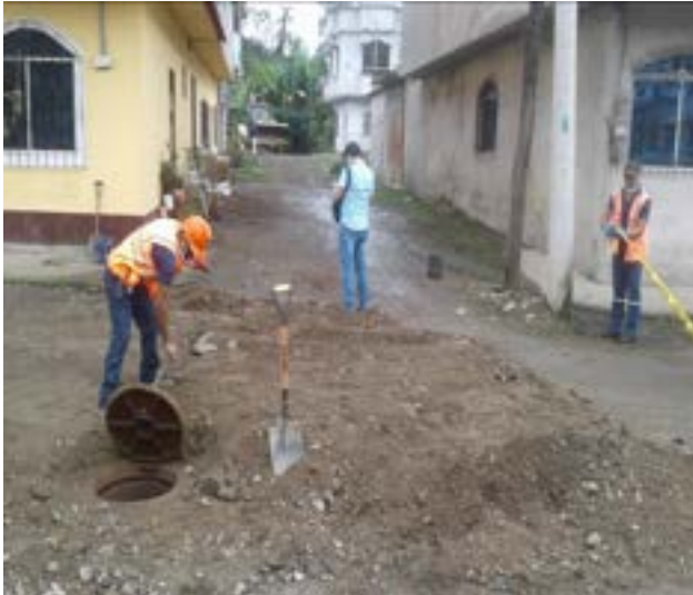
20 Julio – 2020. Excavación para instalar nueva red de alcantarillado sanitario, calle, Pasaje A y Cristóbal Colon, Maquinaria Municipal
