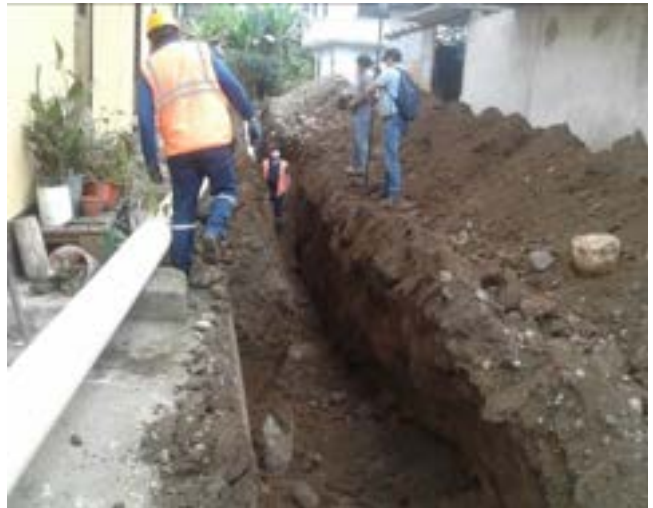
20 Julio – 2020. Excavación para instalar nueva red de alcantarillado sanitario, calle, Pasaje A y Cristóbal Colon, Maquinaria Municipal
