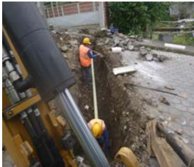
14 Enero – 2020. Excavación para guía de alcantarillado sanitario, en la calle; Eloy Chicaiza y Martín Ortega, Maquinaria Municipal
