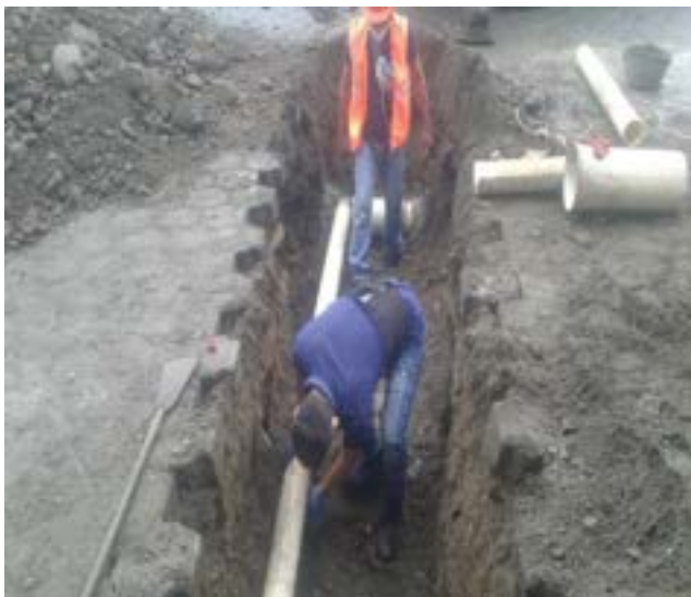
4 Mayo – 2020. Excavación Por alcantarillado sanitario colapsado, en la calle 4 de Diciembre y Juan León Mera, Maquinaria Alquilada.
