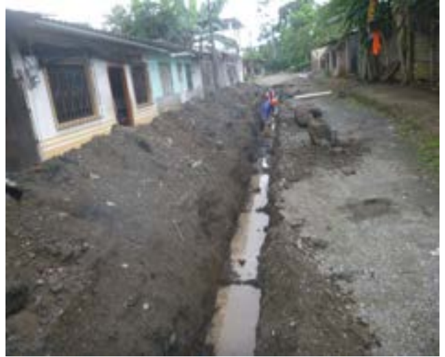
19 Marzo – 2020. Excavación para cambio de tubería de alcantarillado colapsado, en la calle; Pasaje entre Miguel Andrade y Transversal H, Maquinaria Municipal
