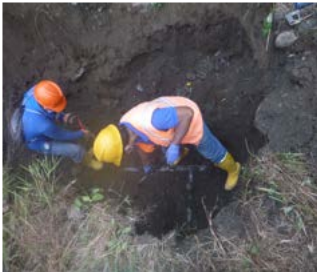
3 Junio – 2020. Excavación para instalar nueva red de agua potable junto a lotización Frutipan , vía Buenos Aires, Maquinaria Municipal
