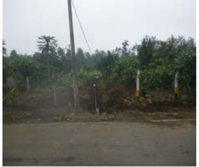
2 Junio – 2020. Excavación para instalar nueva red de agua potable junto a lotización Frutipan , vía Buenos Aires, Maquinaria Municipal
