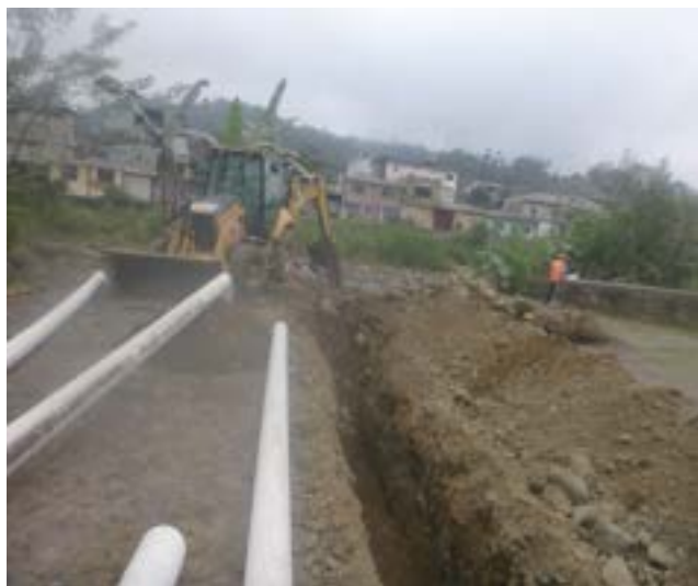
25 Septiembre – 2020. Excavación para instalar nueva red de alcantarillado sanitario, calle Riobamba y Simón Bolívar, Maquinaria Municipal
