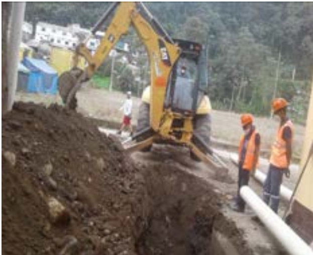
20 Julio – 2020. Excavación para instalar nueva red de alcantarillado sanitario, calle, Pasaje A y Cristóbal Colon, Maquinaria Municipal
