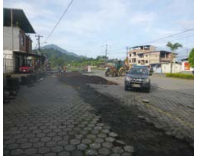
7 Abril – 2020. Excavación para cambio de red matriz de alcantarillado sanitario, en la calle; Av. Los Puentes entre 10 de Agosto y Jaime Cabrera, Maquinaria Municipal
