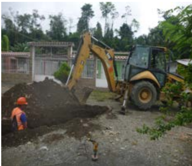
14 Enero – 2020. Excavación para cambio de tubo de alcantarillado sanitario, en la calle; Eugenio Espejo y Cesar Calvopiña, Maquinaria Municipal
