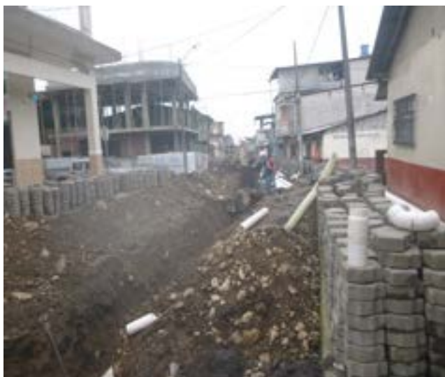
29 Diciembre – 2020. Excavación para reponer nueva red de alcantarillado sanitario, calle Gómez Rendón, Maquinaria Municipal.
