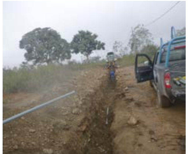
15 Octubre – 2020. Excavación para instalar nueva red de agua potable, sector San Jorge, Maquinaria Municipal
