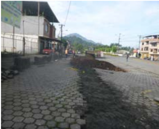
7 Abril – 2020. Excavación para cambio de red matriz de alcantarillado sanitario, en la calle; Av. Los Puentes entre 10 de Agosto y Jaime Cabrera, Maquinaria Municipal
