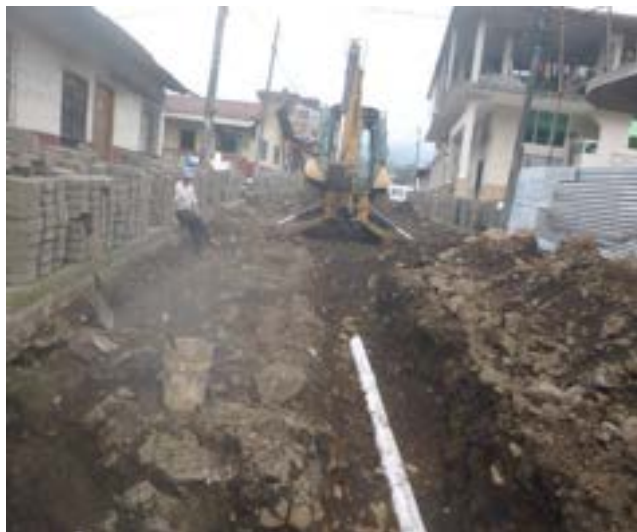
29 Diciembre – 2020. Excavación para reponer nueva red de alcantarillado sanitario, calle Gómez Rendón, Maquinaria Municipal.
