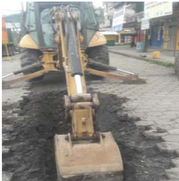
4 Mayo – 2020. Excavación Por alcantarillado sanitario colapsado, en la calle 24 de Mayo y 9 de Octubre, Maquinaria Alquilada.
