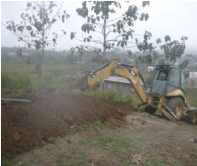
15 Octubre – 2020. Excavación para instalar nueva red de agua potable, sector San Jorge, Maquinaria Municipal
