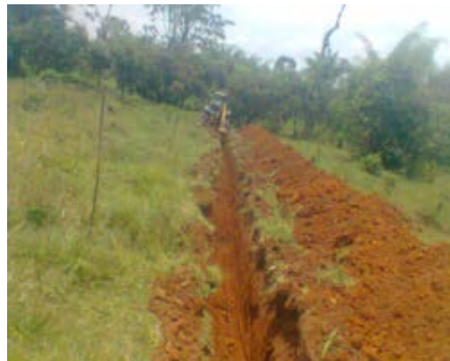
25 Agosto – 2020. Excavación por extensión de red en el sector Luz de América, Maquinaria Alquilada.
