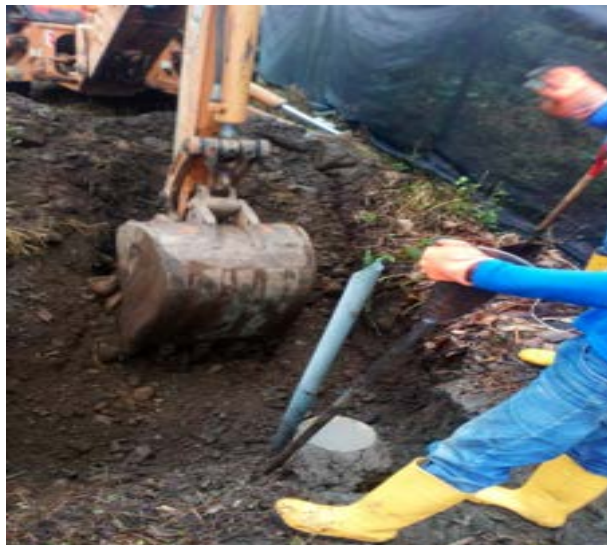
3 Junio – 2020. Excavación para instalar nueva red de agua potable junto a lotización Frutipan , vía Buenos Aires, Maquinaria Municipal
