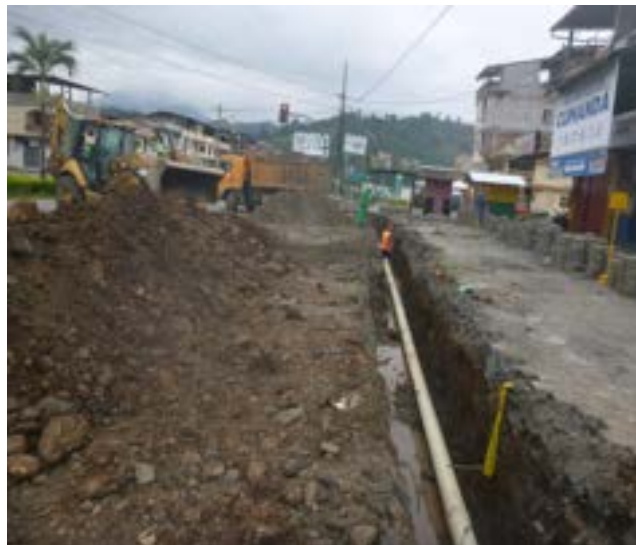
8 Abril – 2020. Excavación y relleno por cambio de red matriz de alcantarillado sanitario, en la calle; Av. Los Puentes entre 10 de Agosto y Jaime Cabrera, Maquinaria Municipal
