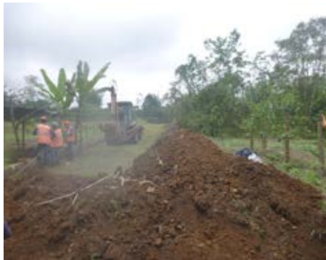
25 Agosto – 2020. Excavación por extensión de red en el sector Luz de América, Maquinaria Alquilada.
