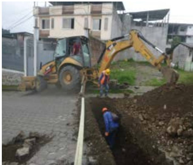
14 Enero – 2020. Excavación para guía de alcantarillado sanitario, en la calle; Amazonas y 4 de Diciembre, Maquinaria Municipal
