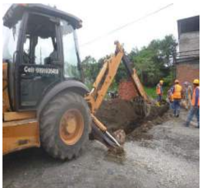
21 Mayo – 2019 Excavación para guía nueva de alcantarillado sanitario, ubicado en las calles Eloy Chicaiza y Eloy Cuadrado
