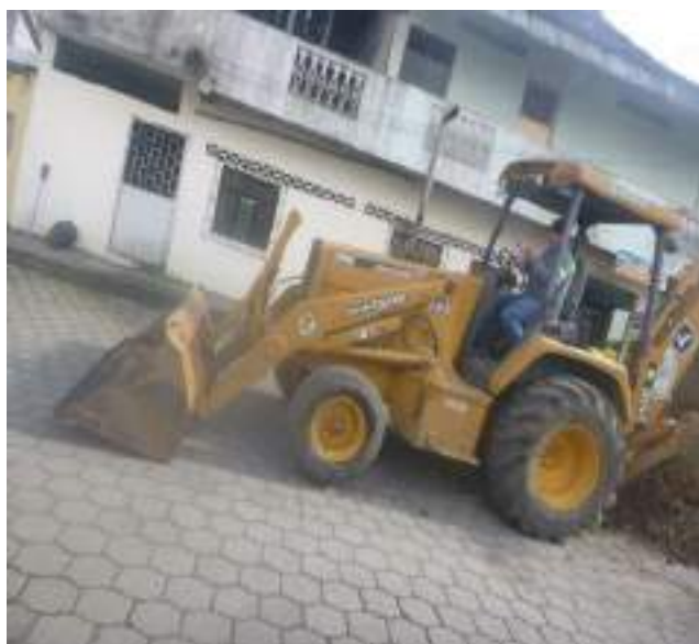
4 Enero - 2019. Excavación para reparación de alcantarillado sanitario colapsado en a calle: Jaime Cabrera entre P. Constituyente y P.V. Maldonado
