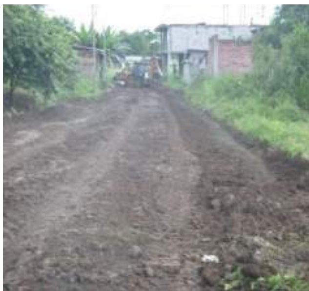
13 Febrero – 2019. Relleno de zanja por extensión de red de agua potable en la calle: Gómez Rendón entre Manuel Cahuana y Segundo Merino.
