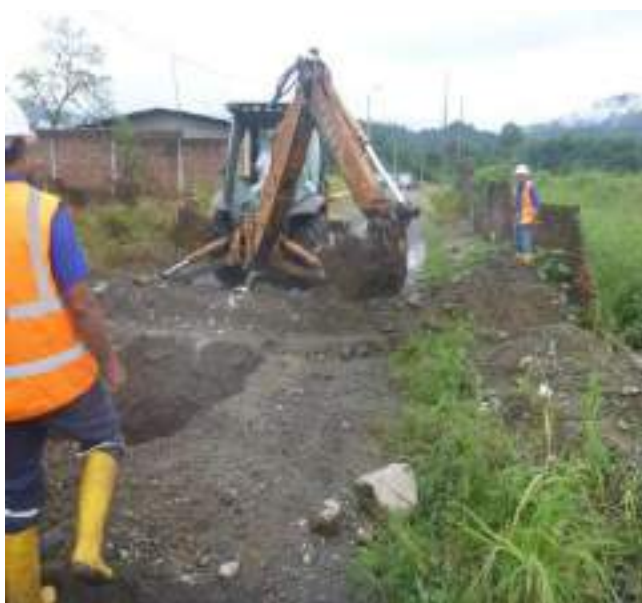
12 Febrero - 2019. Excavación para extensión de red de alcantarillado sanitario en la calle: Segundo Merino, entre Gómez Rendón y 10 de Agosto.
