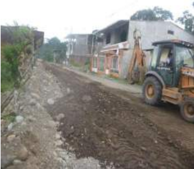
10 Abril – 2019. Excavación extensión de red principal de agua potable en la calle: Eloy Chicaiza entre Martin Ortega y Miguel Andrade.
