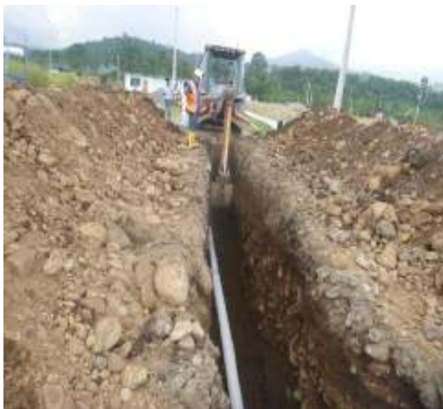
12 Febrero - 2019. Excavación para extensión de red de alcantarillado sanitario en la calle: Segundo Merino, entre Gómez Rendón y 10 de Agosto.
