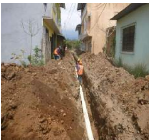
16 Septiembre – 2019. Excavación para cambio de tubería por colapso de alcantarillado sanitario, en la calle; Pasaje 2 entre P. Constituyente y Abdón Calderón.
