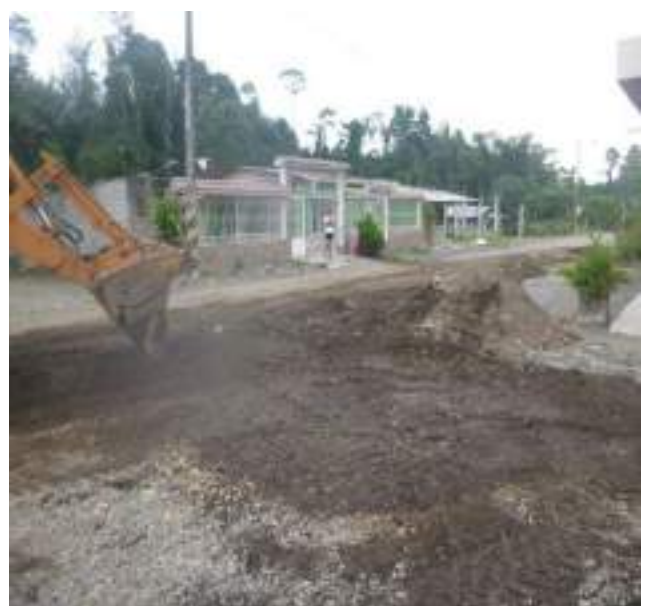
9 Abril – 2019. Excavación extensión de red principal de agua potable en la calle: Eloy Chicaiza entre Martin Ortega y Miguel Andrade.
