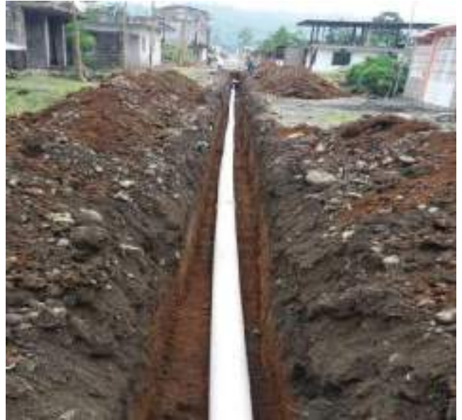
12 Abril – 2019. Excavación para extensión de red de alcantarillado sanitario en la calle: Riobamba entre Cesar Calvopiña y Perimetral.
