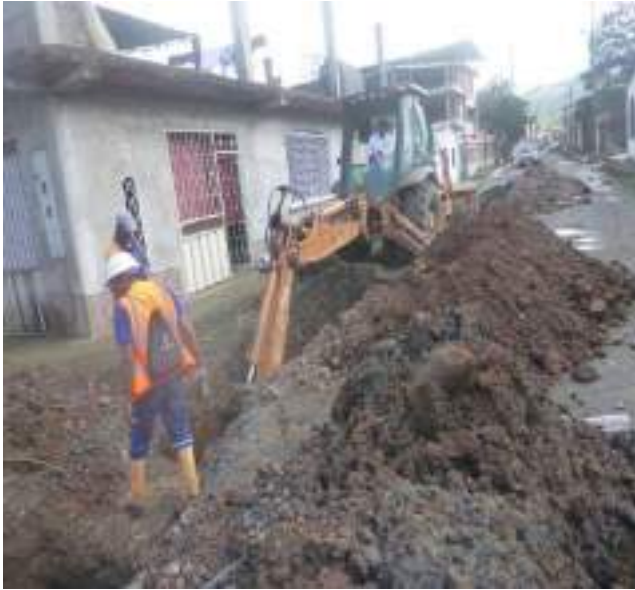
19 Marzo – 2019. Excavación para cambio de tubería de alcantarillado sanitario en la Calle: 24 de Mayo y Celinda Muñoz.
