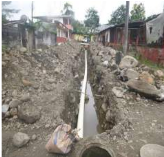
25 de Junio- 2019. Excavación en alcantarillado colapsado, se realiza un cambio de Red Principal
