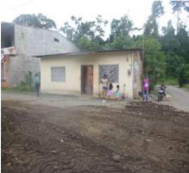
10 Abril – 2019. Excavación extensión de red principal de agua potable en la calle: Eloy Chicaiza entre Martin Ortega y Miguel Andrade.
