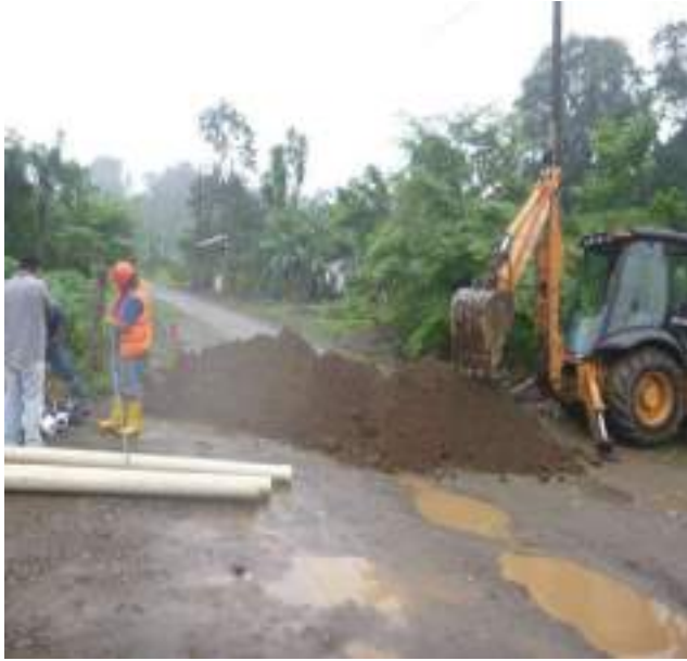
21 Mayo – 2019. Excavación para guía nueva de agua potable y alcantarillado sanitario, ubicado en las calles Eloy Chicaiza y Miguel Andrade
