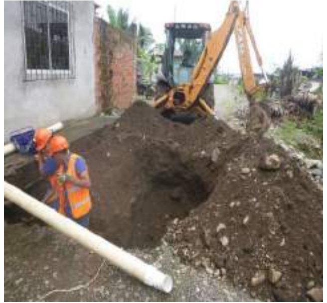
21 Mayo – 2019 Excavación para guía nueva de alcantarillado sanitario, ubicado en las calles Pasaje y Miguel Andrade
