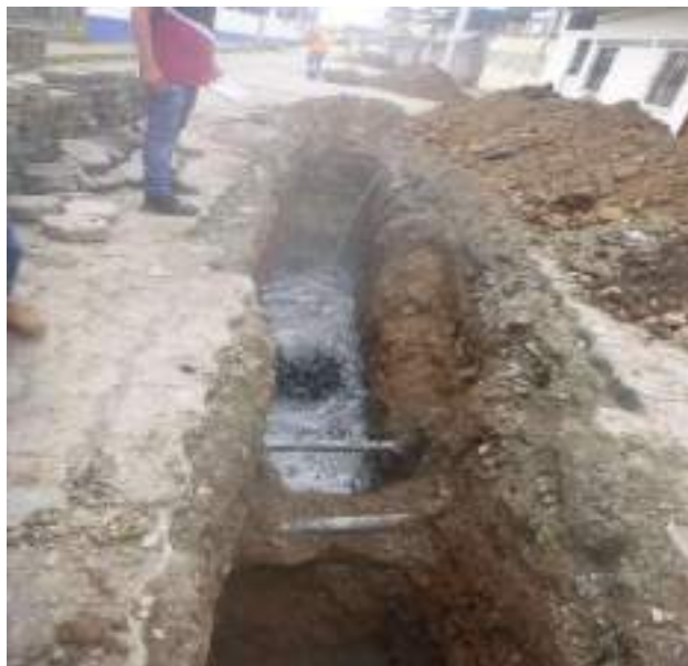
3 Enero - 2019. Excavación para reparación de alcantarillado sanitario colapsado en a calle: Jaime Cabrera entre P. Constituyente y P.V. Maldonado
