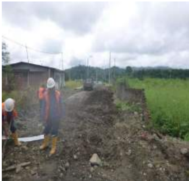
13 Febrero – 2019. Relleno de zanja por extensión de red de agua potable en la calle: Segundo Merino, entre Gómez Rendón y 10 de Agosto.
