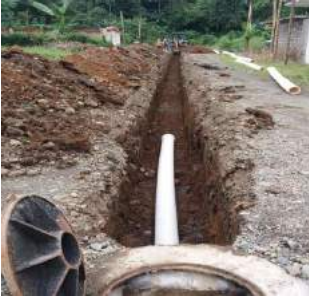
12 Abril – 2019. Excavación para extensión de red de alcantarillado sanitario en la calle: Riobamba entre Cesar Calvopiña y Perimetral.
