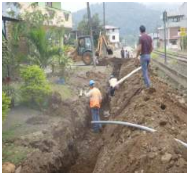
19 Septiembre – 2019. Excavación para reubicar red de agua potable y acometidas, en la calle; Eloy Alfaro entre Jaime Cabrera y Ricardo Espinoza.
