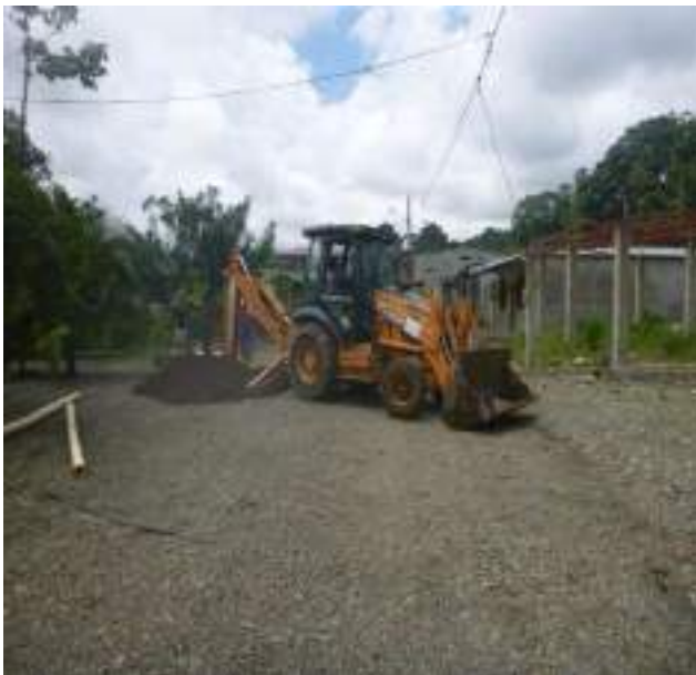
21 Mayo – 2019 Excavación para guía nueva de alcantarillado sanitario, ubicado en las calles Eloy Chicaiza y Martin Ortega
