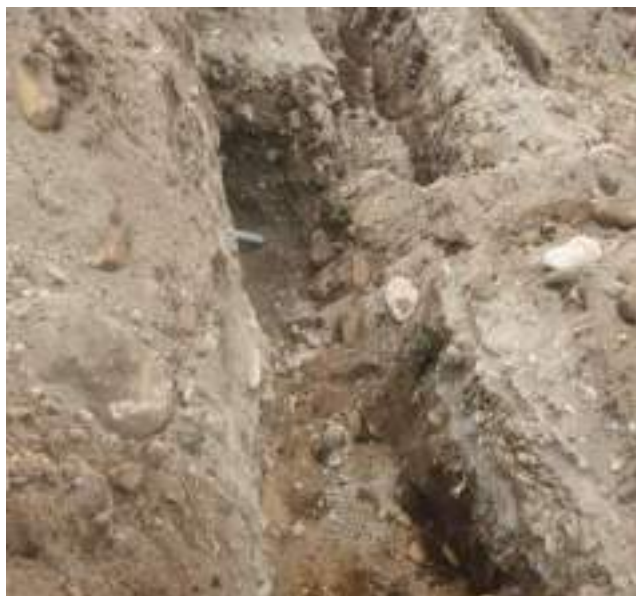
19 Septiembre – 2019. Excavación para reubicar red de agua potable y acometidas, en la calle; Eloy Alfaro entre Jaime Cabrera y Ricardo Espinoza.
