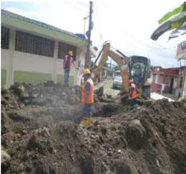
28 Mayo – 2019. Excavación replazo de tubería de alcantarillado sanitario colapsado, en la calle; Pasaje entre Eloy Alfaro y 24 de Mayo.
