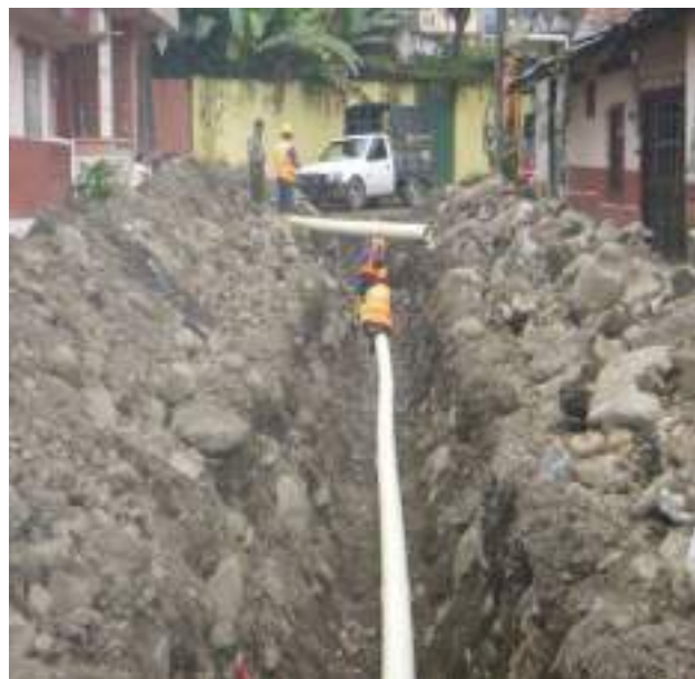
25 de Junio- 2019. Excavación en alcantarillado colapsado, se realiza un cambio de Red Principal
