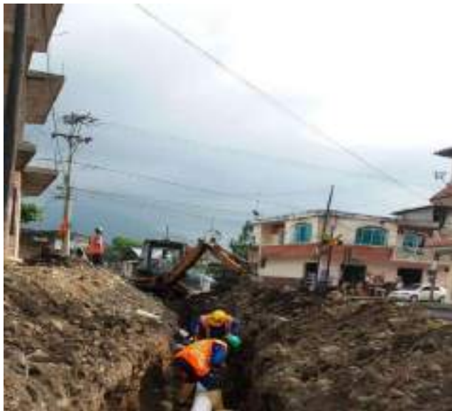
11 Abril – 2019. Excavación para reparar alcantarillado sanitario colapsado, en la calle Eloy Alfaro entre 9 de Octubre y Simón Bolívar.
