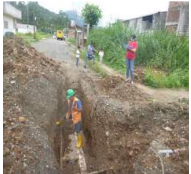
19 Marzo – 2019. Excavación para cambio de tubería de alcantarillado sanitario en la Calle: 24 de Mayo y Celinda Muñoz.
