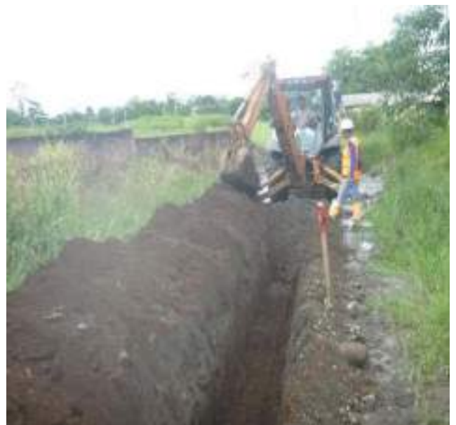
11 Febrero - 2019. Excavación para extensión de red de alcantarillado sanitario en la calle: Gómez Rendón entre Manuel Cahuana y Segundo Merino.
