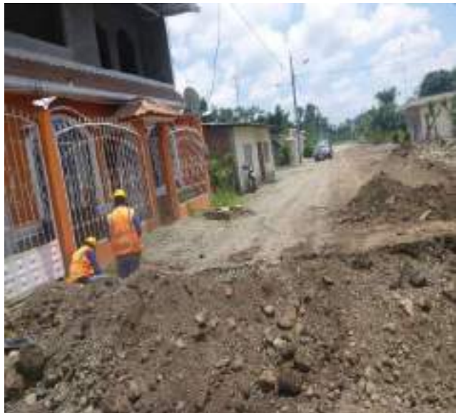
10 Abril – 2019. Excavación para guía nueva de alcantarillado en la calle: Pasaje y Martin Ortega
