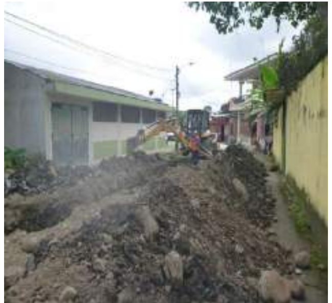
28 Mayo – 2019. Excavación replazo de tubería de alcantarillado sanitario colapsado, en la calle; Pasaje entre Eloy Alfaro y 24 de Mayo.
