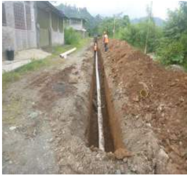
4 Abril – 2019. Excavación para extensión de red principal en la calle Transversal i, entre Simón Bolívar y Longitudinal 3.
