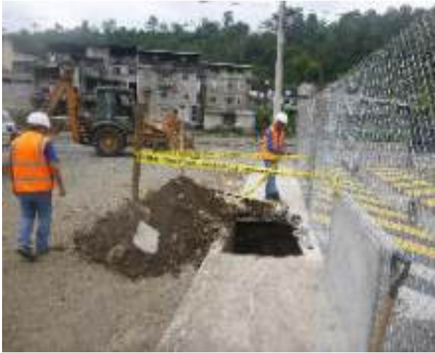
Agosto 23 - 2018. Excavación para guía nueva de alcantarillado sanitario, en la Calle: P. V. Maldonado y Cristóbal Colon.
