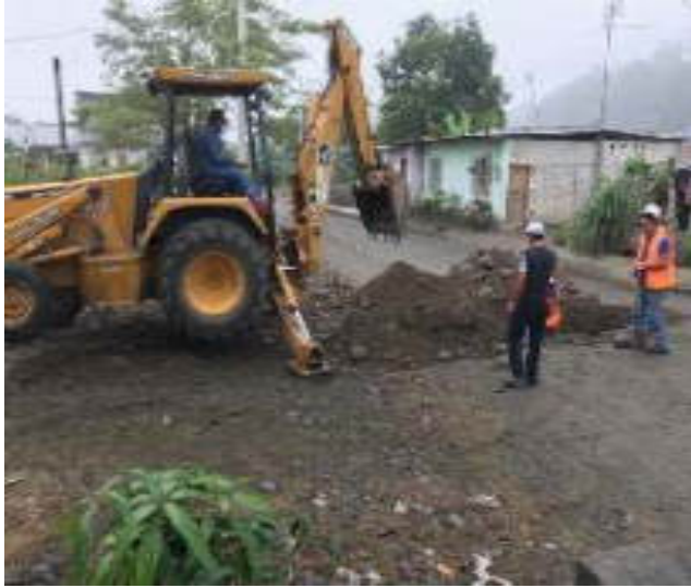
Julio - 2018. Excavación para extensión de red de agua potable. Calle: Gilberto Vicuña y Atahualpa
