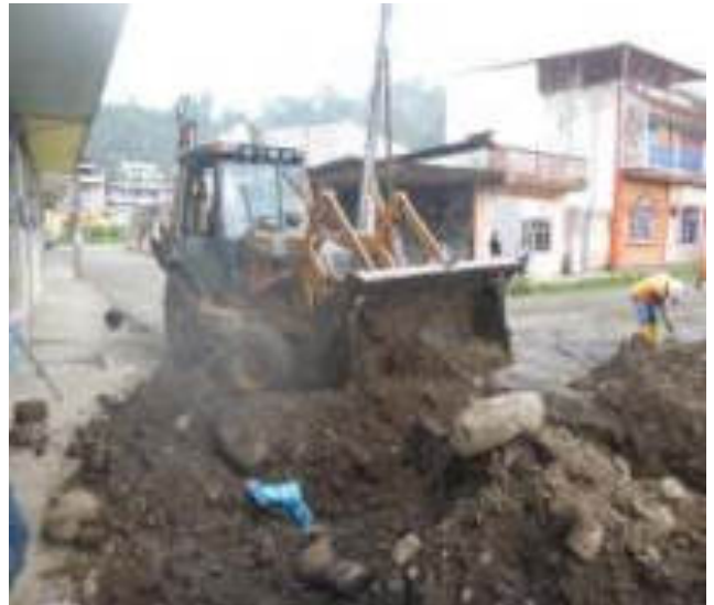
Diciembre 14 - 2018. Excavación para reparación de alcantarillado colapsado en la calle. Juan León Mera y Atahualpa.
