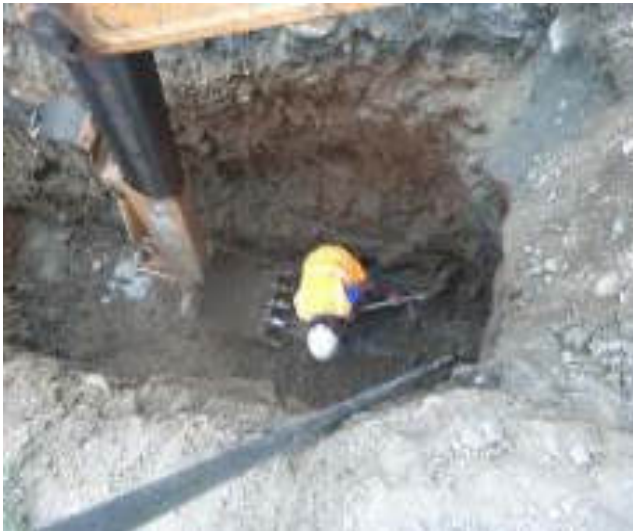
Octubre 29 - 2018. Excavación para destapar alcantarillado colapsado, en la Calle: Francisco Chávez y 5 de Junio.
