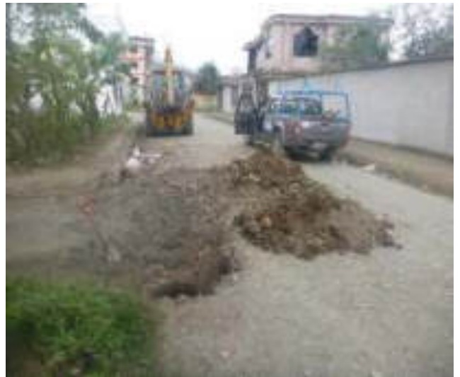
Octubre 25 - 2018. Limpieza de Pozos de Alcantarillado Sanitario: Barrio Víctor Corral Mantilla.
