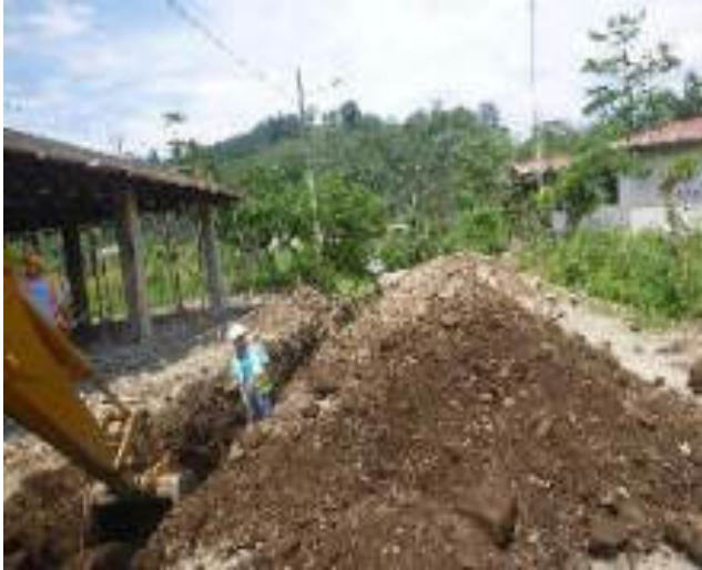
Enero - 2018. Excavación para extensión de red de agua potable calle: Martin Ortega entre 4 de Diciembre y Eloy Chicaiza.
