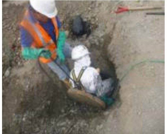
Octubre 25 - 2018. Limpieza de Pozos de Alcantarillado Sanitario: Barrio 9 de Diciembre.
