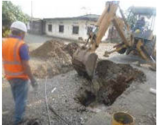
Agosto 30 - 2018. Excavación para destapar alcantarillado colapsado, en la Calle: Gómez Rendón y Baltazar Curillo.
