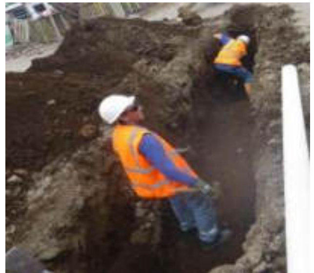
Septiembre 13 - 2018. Excavación para guía nueva de alcantarillado sanitario en la calle: 9 de Octubre y Eloy Alfaro.
