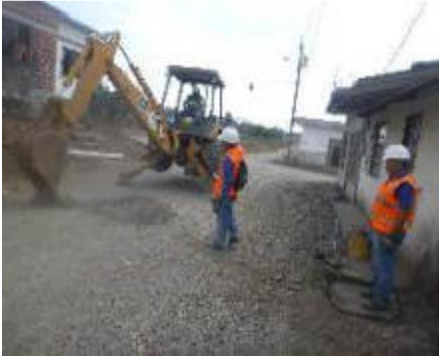
Agosto 30 - 2018. Excavación para destapar alcantarillado colapsado, en la Calle: 10 de Agosto y Baltazar Curillo.
