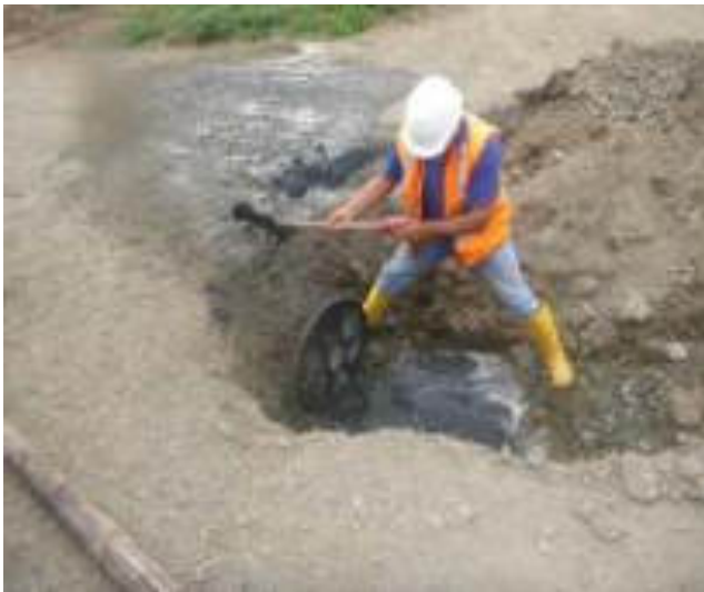
Octubre 25 - 2018. Limpieza de Pozos de Alcantarillado Sanitario: Barrio La Marina.
