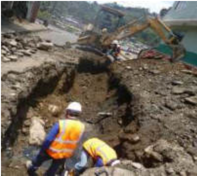
Septiembre 13 - 2018. Excavación para guía nueva de alcantarillado sanitario en la calle: 9 de Octubre y Eloy Alfaro.
