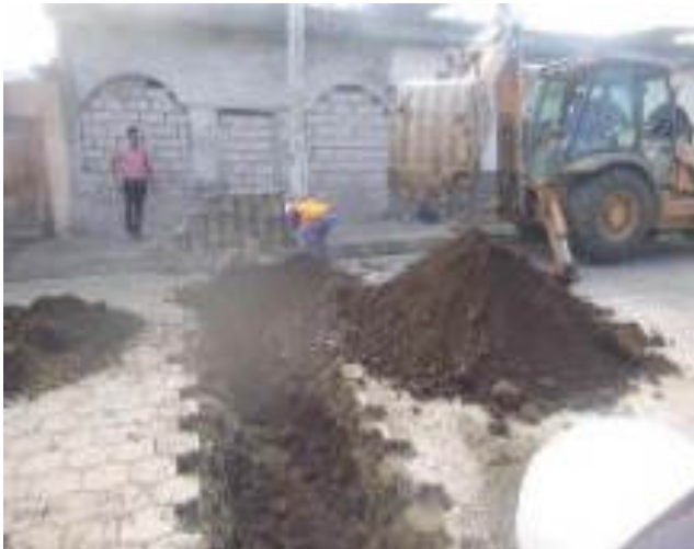
Agosto 23 - 2018. Excavación para guía nueva de Agua Potable, en la Calle: Riobamba y Jaime Cabrera.
