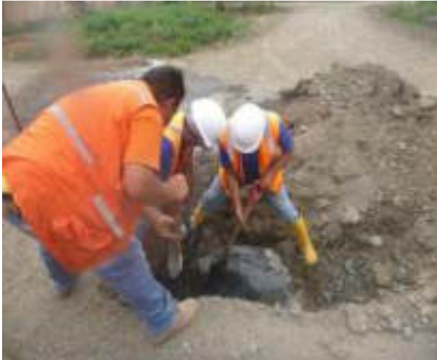
Octubre 25 - 2018. Limpieza de Pozos de Alcantarillado Sanitario: Barrio Los Andes.
