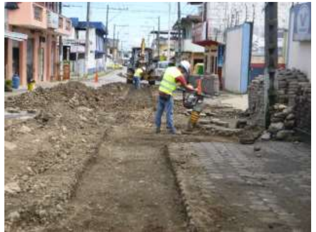
Mayo - 2017. Limpieza de material para adoquinar en la obra de cambio de tubería alcantarillado sanitario en la calle: Jaime Cabrera y Primero de Mayo.
