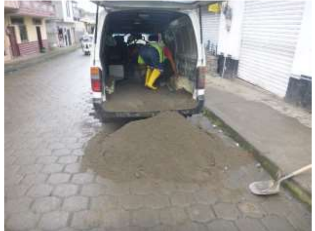
Octubre - 2017. Relleno con arena por cambio de tubería colapsada en la calle: 4 de Diciembre entre Primero de Mayo y Amazonas.
