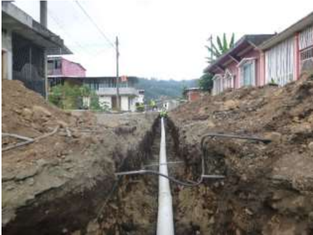
Julio - 2017. Colocación de tubería de Alcantarillado sanitario (200mm). Calle: Eugenio Espejo entre 10 de Agosto y Jaime Cabrera
