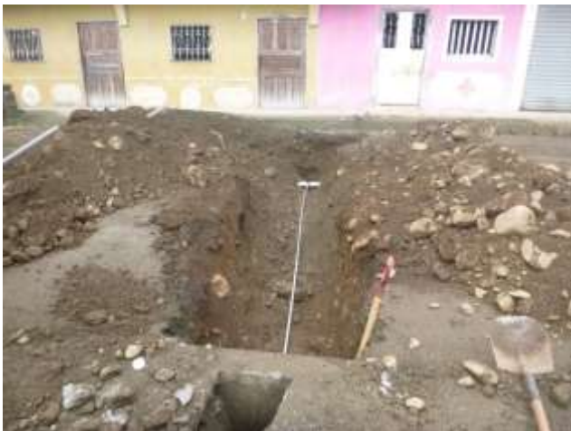
Junio - 2017. Instalación de Guía nueva de agua potable. Calle: Simón Bolívar entre Carlos Espinoza y Digno Espinoza
