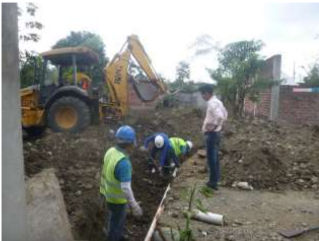
Agosto - 2017. Instalación de acometidas domiciliarias a la nueva red de alcantarillado sanitario. Calle: 24 de Mayo Entre Perimetral y Pasaje 3
