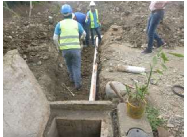
Agosto - 2017. Instalación de acometidas domiciliarias a la nueva red de alcantarillado sanitario. Calle: 24 de Mayo Entre Perimetral y Pasaje 3
