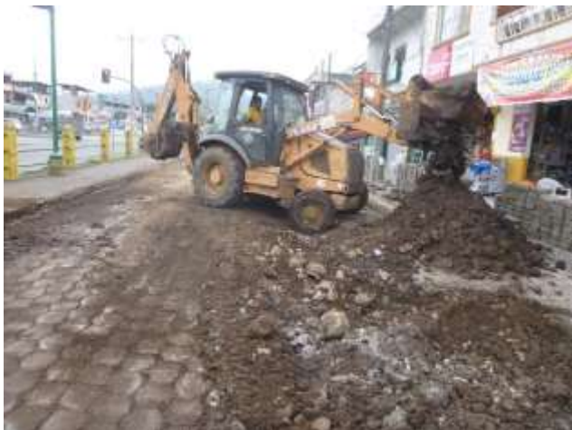
Octubre - 2017. Retiro de material sobrante por cambio de tubería colapsada en la calle: Primero de Mayo entre Gómez Rendón y 10 de Agosto
