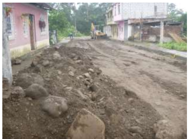
Junio - 2017. Relleno de zanja por excavación de alcantarillado sanitario. Calle: Simón Bolívar entre Carlos Espinoza y Digno Espinoza
