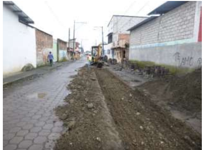
Mayo - 2017. Limpieza de material para adoquinar en la obra de cambio de tubería de alcantarillado sanitario en la calle: Jaime Cabrera y Primero de Mayo.
