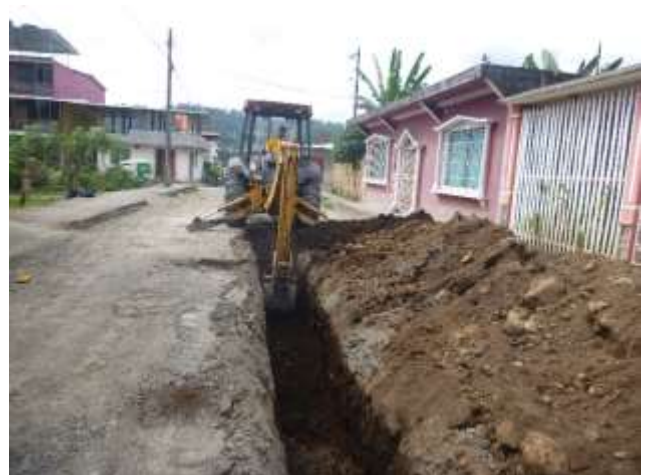
Julio - 2017. Excavación para instalación de tubería de alcantarillado sanitario. Calle: Eugenio Espejo entre 10 de Agosto y Jaime Cabrera
