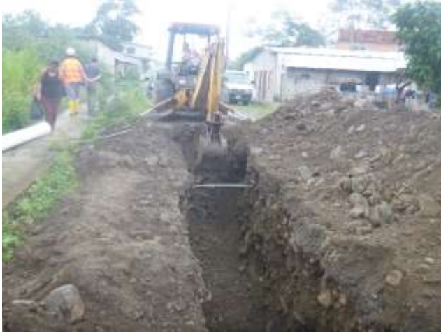
Junio - 2017. Excavación para instalación de red matriz de alcantarillado sanitario. Calle: Simón Bolívar entre Carlos Espinoza y Digno Espinoza
