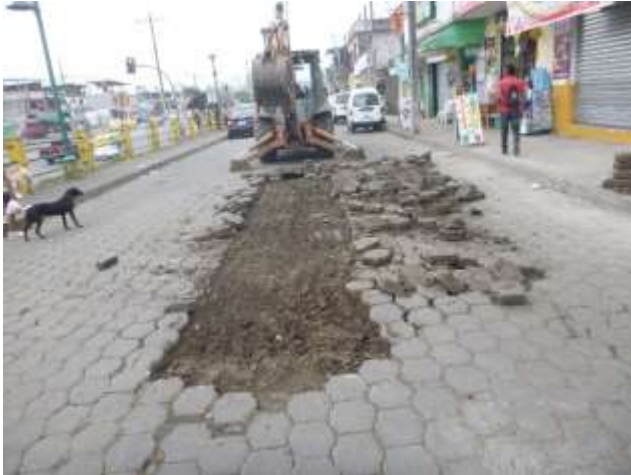
Octubre - 2017. Excavación para cambio de tubería colapsada en la calle: Primero de Mayo entre Gómez Rendón y 10 de Agosto
