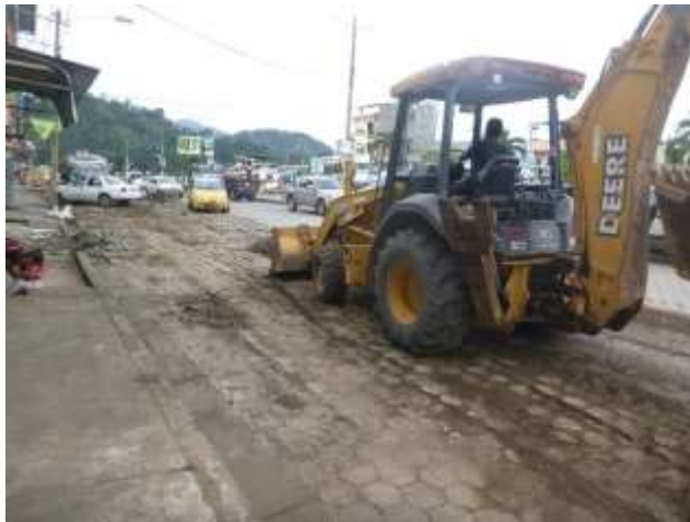
Mayo – 2017. Retiro de material sobrante en la obra de cambio de tubería colapsada de alcantarillado sanitario en la calle: Primero de Mayo y Jaime Cabrera.
