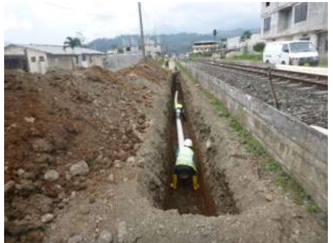
Diciembre - 2017. Instalación de tubería pvc 220mm de alcantarillado sanitario colapsado, en la calle: Eloy Alfaro y Celinda Muñoz
