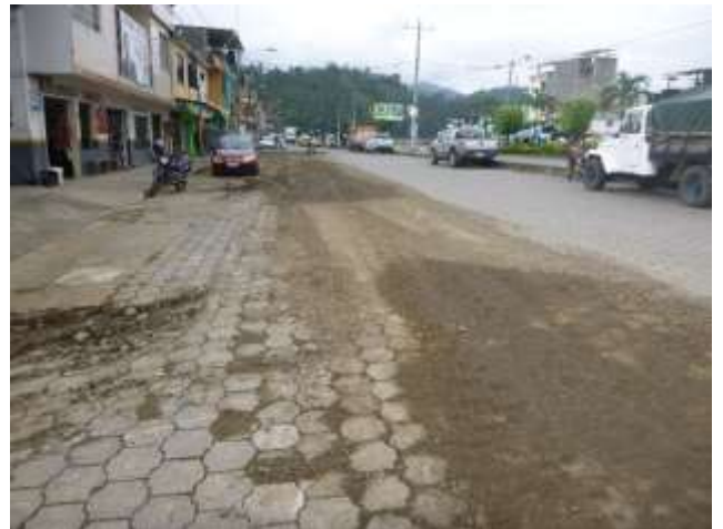
Mayo – 2017. Retiro de material sobrante en la obra de cambio de tubería colapsada de alcantarillado sanitario en la calle: Primero de Mayo y Jaime Cabrera.
