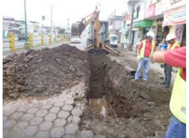
Octubre - 2017. Excavación para cambio de tubería colapsada en la calle: Primero de Mayo entre Gómez Rendón y 10 de Agosto
