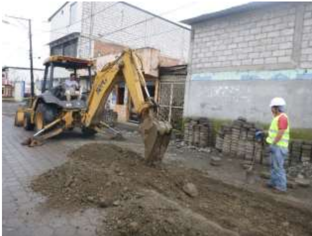
Mayo - 2017. Limpieza de material para adoquinar en la obra de cambio de tubería de alcantarillado sanitario en la calle: Jaime Cabrera y Primero de Mayo.
