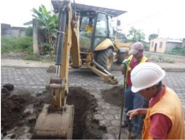
Noviembre - 2017. Excavación para acometida de alcantarillado sanitario en la calle: Jaime Cabrera y 5 de Junio.
