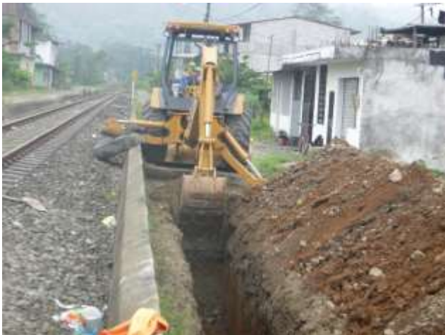
Diciembre - 2017. Excavación para instalación de tubería pvc 220mm de alcantarillado sanitario colapsado, en la calle: Eloy Alfaro y Celinda Muñoz
