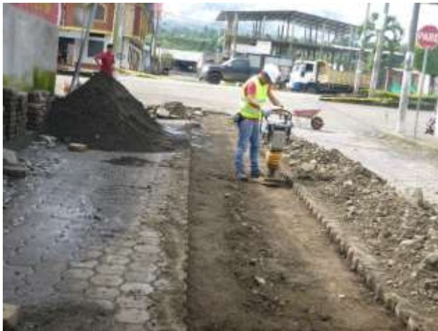
Mayo - 2017. Limpieza de material para adoquinar en la obra de cambio de tubería alcantarillado sanitario en la calle: Jaime Cabrera y Primero de Mayo.
