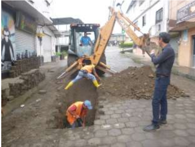
Octubre - 2017. Excavación para cambio de tubería colapsada en la calle: 4 de Diciembre entre Primero de Mayo y Amazonas.
