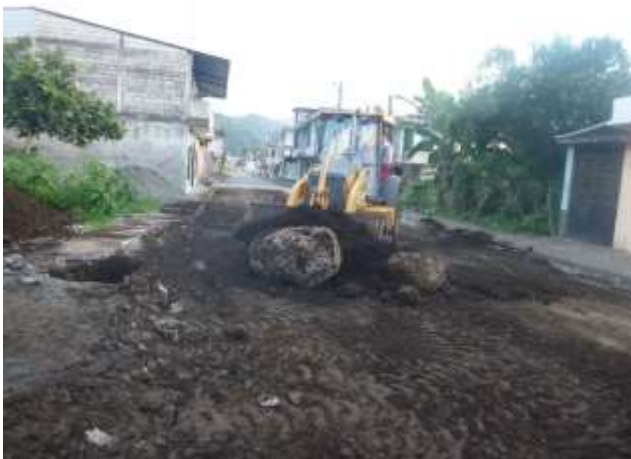
Julio - 2017. Retiro de material sobrante posterior a la ampliación de red de alcantarillado sanitario. Calle: Eugenio Espejo entre 10 de Agosto y Jaime Cabrera
