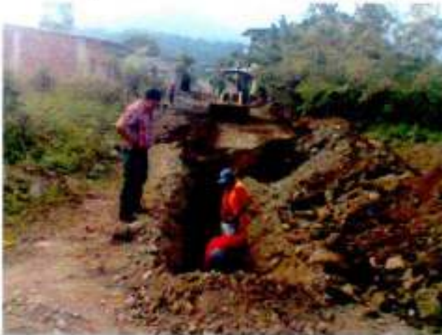
Junio-2016 Excavación para red de agua potable red principal calle: G. Suarez entre Perimetral y Cesar Calvopiña
