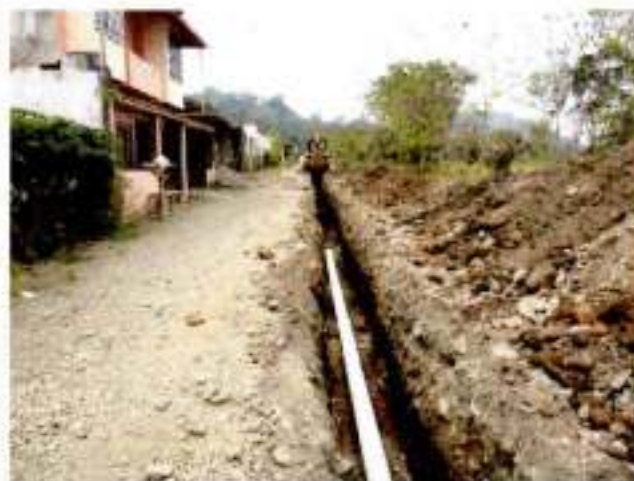
25-Octubre-2016 Instalación de tubería de alcantarillado red principal calle: Transversal I entre Simón Bolívar y 10 de Agosto
