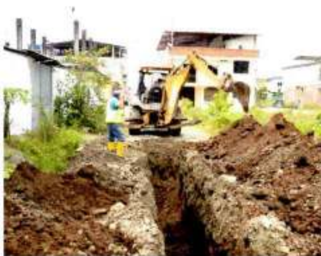
27-Octubre-2016 Excavación Alcantarillado nuevo red principal calle: Gómez Rendón entre Transversal I y 28 de Enero
