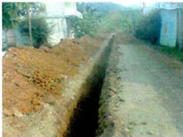
Junio-2016 Excavación para Alcantarillado nuevo red principal calle: G. Suarez entre Perimetral y Cesar Calvopiña
