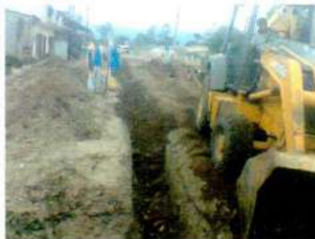
Mayo-2016 Relleno de zanja por Instalación de red de Alcantarillado Sanitario, red principal calle: 9 de Octubre entre Carlos Espinoza y Digno Espinoza
