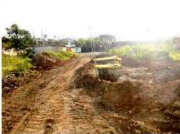
28-Octubre-2016 Relleno en tubería de alcantarillado red principal calle: Transversal I entre Simón Bolívar y 10 de Agosto
