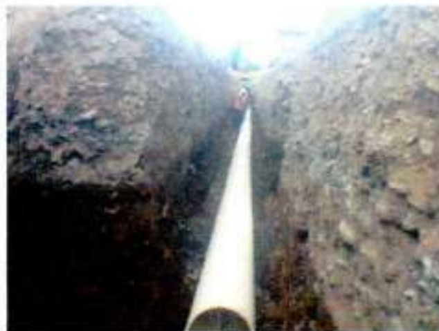
Mayo-2016 Instalación de red de Alcantarillado Sanitario red principal calle: 9 de Octubre entre Carlos Espinoza y Digno Espinoza
