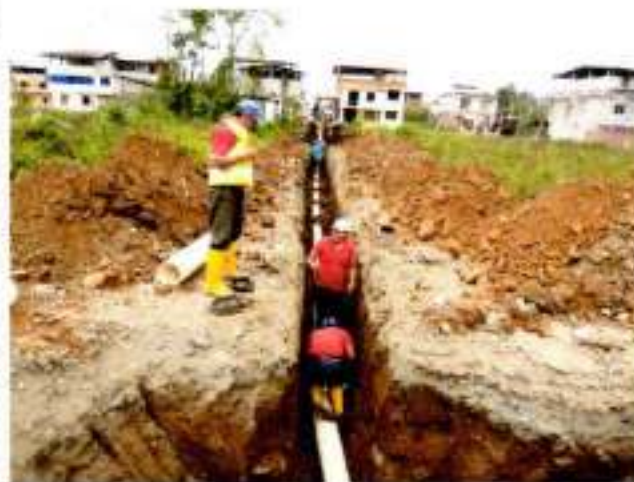
28-Octubre-2016 Instalación de tubería de alcantarillado red principal calle: Gómez Rendón entre Transversal I y 28 de Enero
