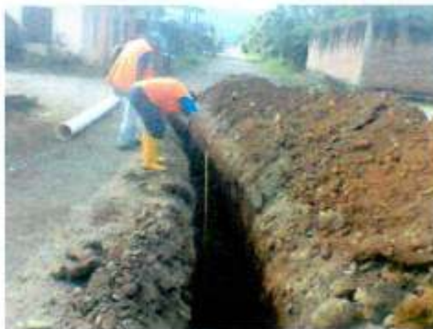
Junio-2016 Relleno de zanja por instalación de Tubería de alcantarillado red principal calle: G. Suarez entre Perimetral y Cesar Calvopiña
