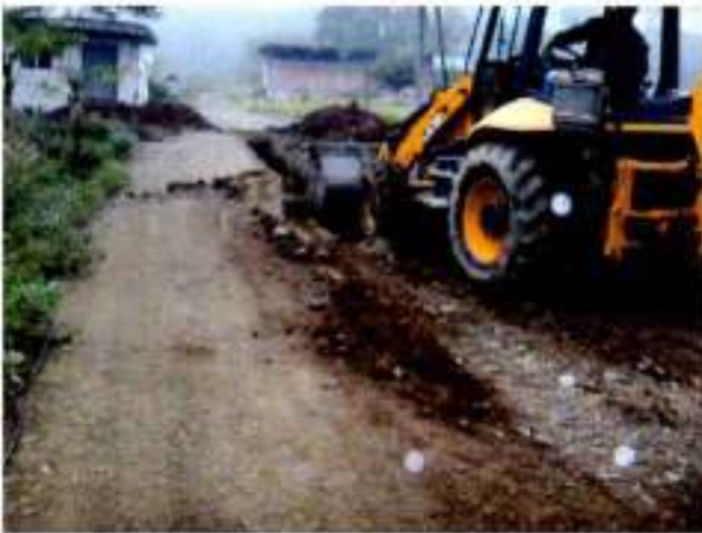
25-Octubre-2016 Relleno de zanja por instalación de Tubería de alcantarillado red principal calle: Transversal I entre Simón Bolívar y 10 de Agosto
