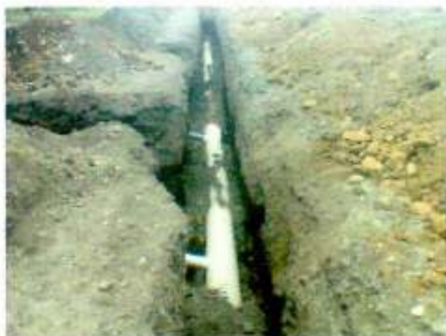
Mayo-2016 Instalación de acometidas domiciliarias calle: 9 de Octubre entre Carlos Espinoza y Digno Espinoza
