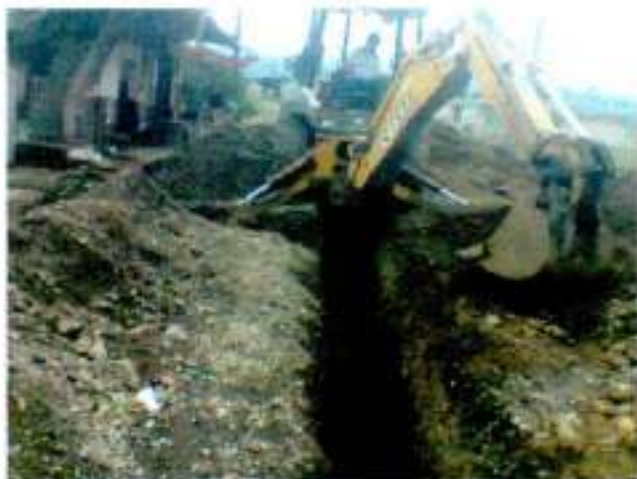
Mayo-2016 Excavación para red de Alcantarillado Sanitario red principal calle: 9 de Octubre entre Carlos Espinoza y Digno Espinoza
